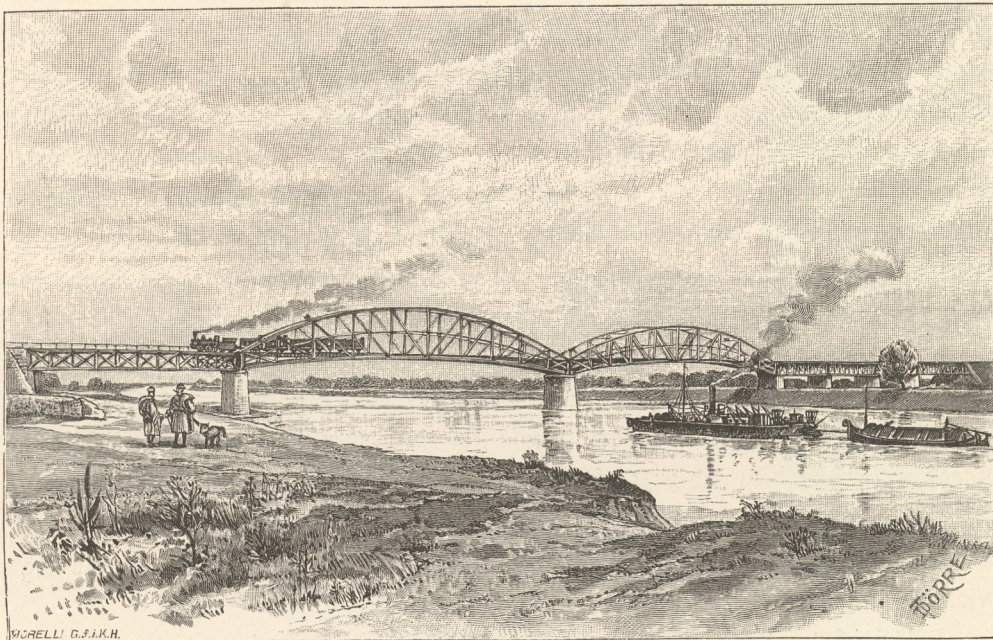
Eisenbahnbrücke bei Szolnok.
