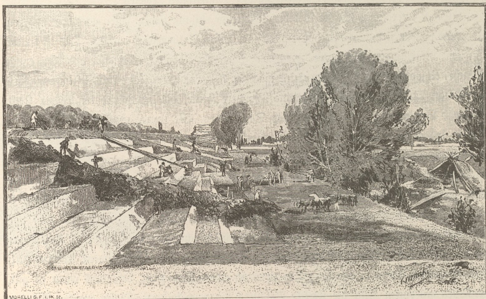
Arbeit auf dem Damm.
