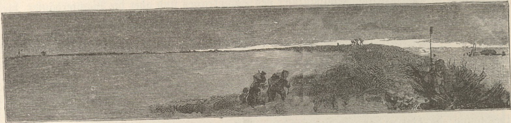
Damm zwischen der Hochflut und dem Binnenwasser.
