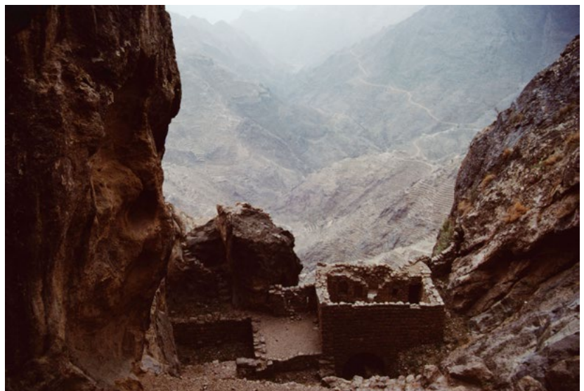
Abb. 224 Die alte Wehranlage von Schahara bestand einst aus einem mehrgeschoßigen Torbauwerk in einer engen Schlucht, das die volle Breite ausfüllt. Im Torbau gelangt man über zahlreiche Treppen und Stockwerke zum hinteren höheren Abschnitt der Schlucht. Durch Versperrung und Sicherung dieses Torbauwerks konnte der Zugang nach Schahara blockiert werden. Dieser Aufgang wurde im Januar 1992 nicht mehr benutzt, kaum noch begangen und war bereits dem Verfall ausgesetzt.
