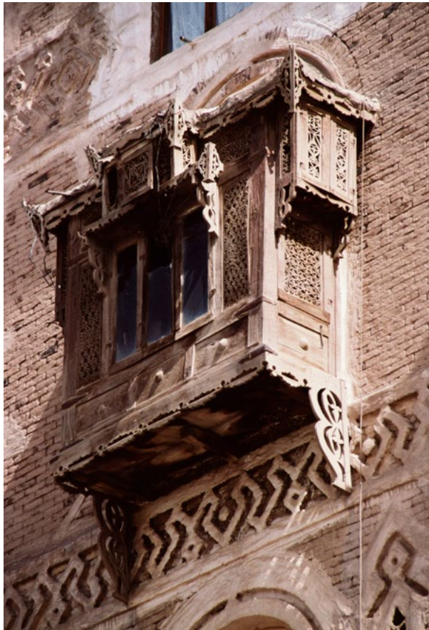
Abb. 31 Hölzerner Erker aus dem 19. Jh. mit reichen Schnitzereien und Resten von farblicher Ge- staltung.
