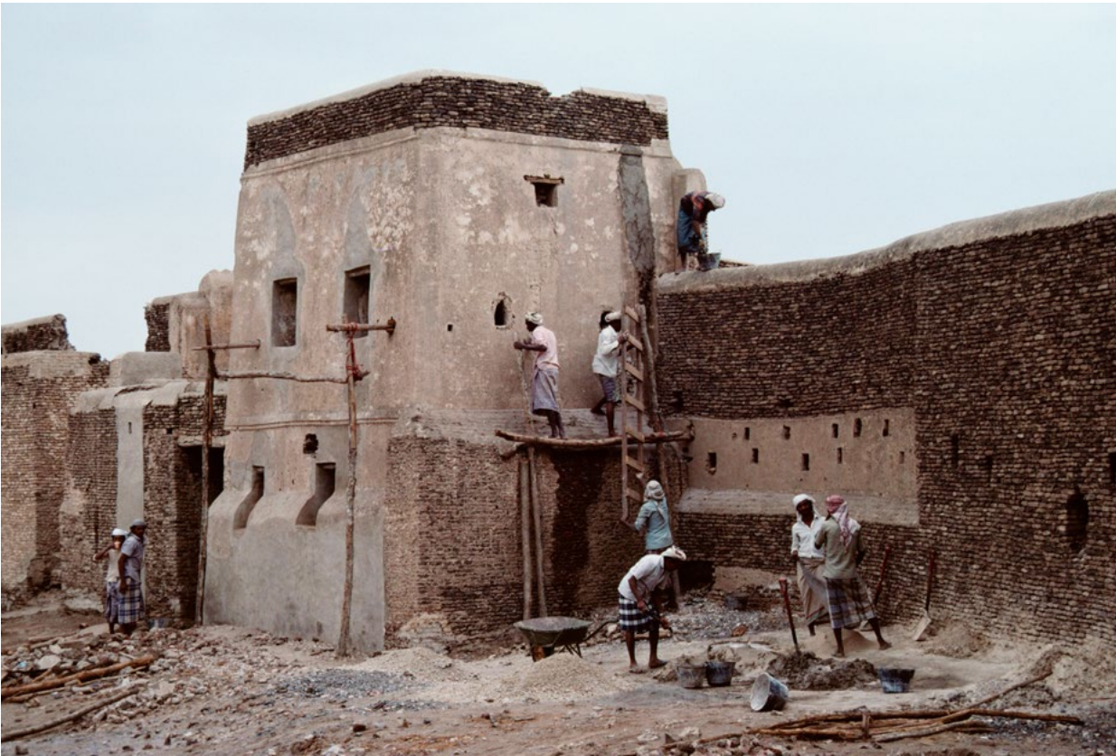
Abb. 264 Die alte Festung von Zabid wurde gerade während meines Aufenthaltes stadttarchäologisch untersucht und saniert.
