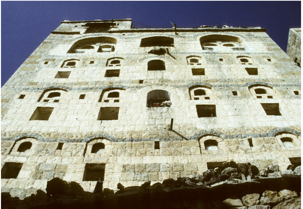
Abb. 249 Das Mauerwerk dieser Häuser in Kuchlan ist sehr sorgfältig ausgeführt. Der Dekor beruht vor allem auf der Verwendung von Steinen unterschiedlicher Färbung bei vielen der Bauten.
