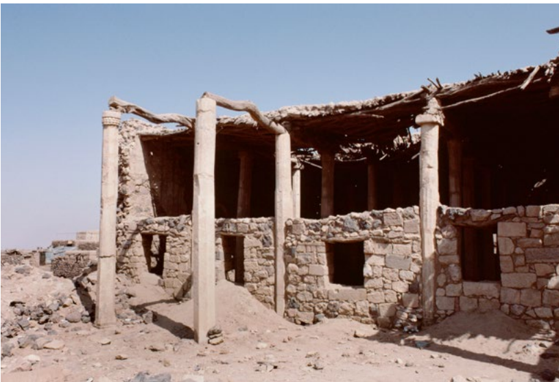
Abb. 65 Die Moschee war mit einem hohen, flachen Dach überspannt. Im Norden, Osten und Süden war sie durch hohe Mauern geschlossen und hatte nach Westen im Innern eine halbhohe aus Steinen gemauerte Wand mit vier Fenstern und zwei Türen. Der westlich davon gelegene Teil der Moschee scheint über keine Außenwand verfügt zu haben.
