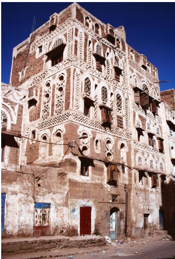
Abb. 14 Bei diesen Häusern sind die alten Holztüren bereits alle durch Blechtüren ersetzt worden. Die Wasserzuleitungen an der Seite stören genauso wie die Kabel an der Hauptfassade. An dieser Fassade finden sich noch mehrere aus der osmanischen Zeit stammende Erker.
