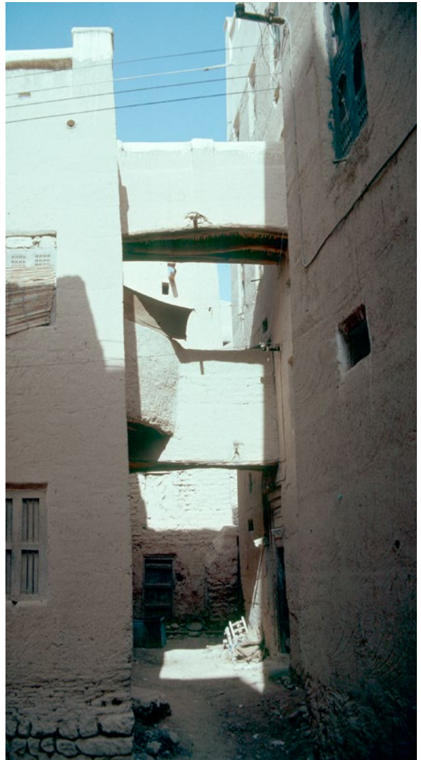
Abb. 120 Brücken zwischen zwei Geschlechtertürmen. Hier wurden zwei dritte und zwei zweite Geschoße miteinander verbunden. Solche Brücken wurden vor allem für ältere Familienangehörige gebaut, damit sie ihre Altersgenossen im Nachbarhaus besuchen können, ohne dafür die steilen Treppen steigen zu müssen.
