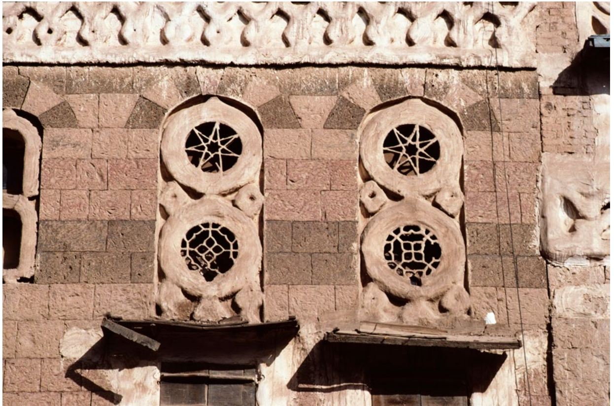
Abb. 10 Einer der Wohntürme in der Altstadt von Sanaa. Unten bilden sorgfältig rektangulierte Natursteine, oben gebrannte Ziegel das Mauerwerk.
