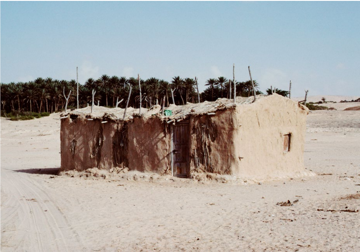
Abb. 178 Einfache Hütte in Ain, konstruiert aus Holz und Schilf. Der grobe Verputz mit Lehm macht das Gebäude einigermaßen staubdicht bei Staubstürmen.
