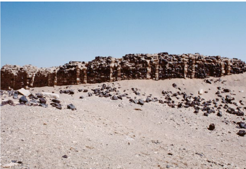
Abb. 60 Bei der Umfassungsmauer des ovalen Vorplatzes fehlen die Blendsteine bereits über weite Strecken. So werden etliche der insgesamt 64 Quermauern in der vier Meter dicken Mauerkonstruktion sichtbar, von denen hier einige zu sehen sind.
