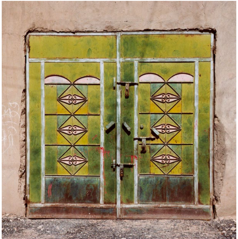
Abb. 287 Farbig gestaltete Blechtür in Rauda.
