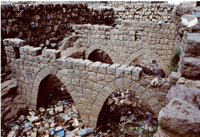
Abb. 277 Die alte Zisterne aus der osmanischen Zeit wurde als Mülldeponie verwendet. Das Wasser wurde inzwischen in große Blechbehälter auf den Dächern der Häuser gepumpt.
