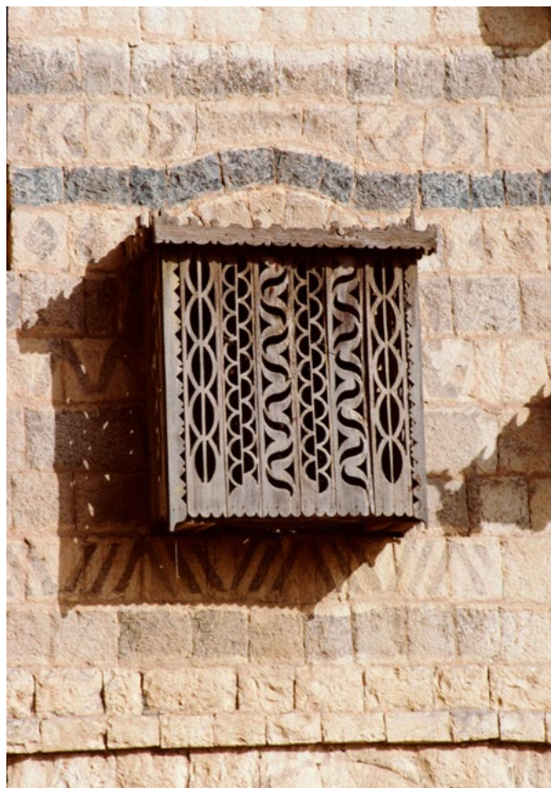
Abb. 252 Holzerker mit starkem osmanischem Einfluss.
