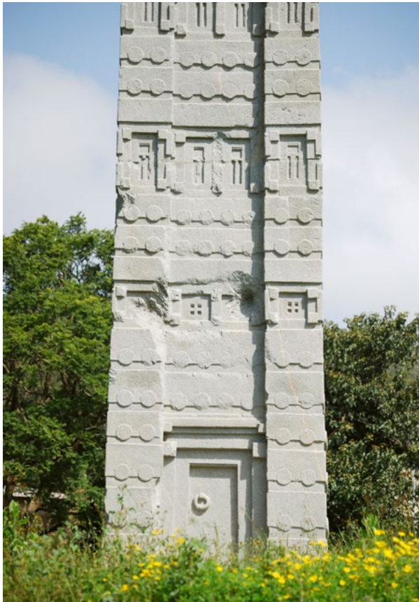
Abb. 315 Stele 2 in Axum zeigt eine Wandkonstruktion mit "Affenköpfen", das sind die aus der Wand vortretenden Querhölzer, die das Mauerwerk zusammenhalten und die auf Zug beansprucht werden. Diese Konstruktion entspricht jener der Kirche von Debre Damo.
