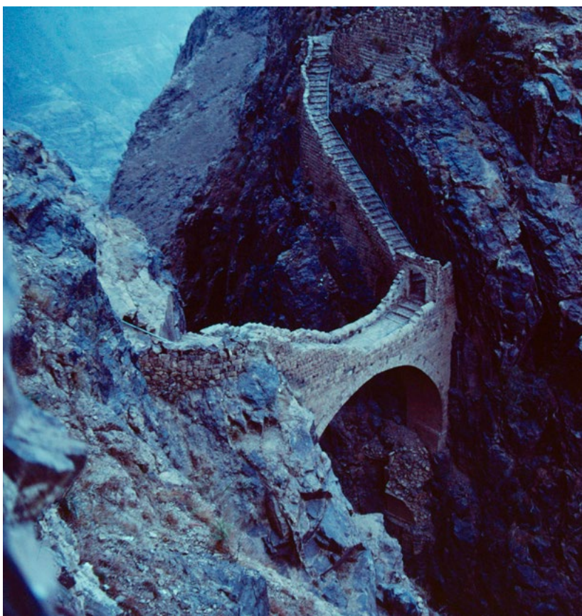
Abb. 225 In der Langzeitaufnahme der berühmten Brücke nach Schahara bei fast völliger Finsternis erkennt man gut die tiefer liegenden Reste von mindestens zwei Vorgängerbrücken, die auch bereits die Schlucht überspannt hatten.
