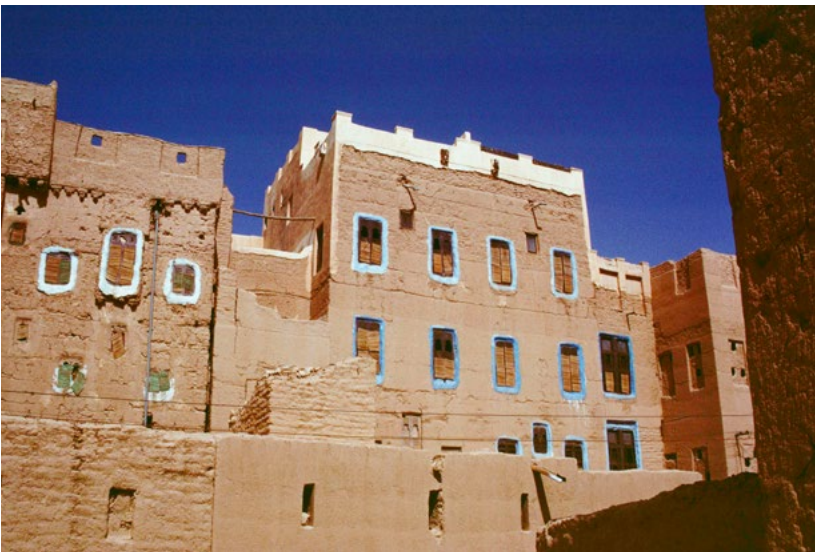
Abb. 153 Die Innenraumfarben dieser Häuser in Sif werden über die Fensterlaibungen nach außen zu einer Art Fasche um die Fenster vorgezogen. Sie bilden einen reizvollen Kontrast zur Lehmfarbe der Mauern.
