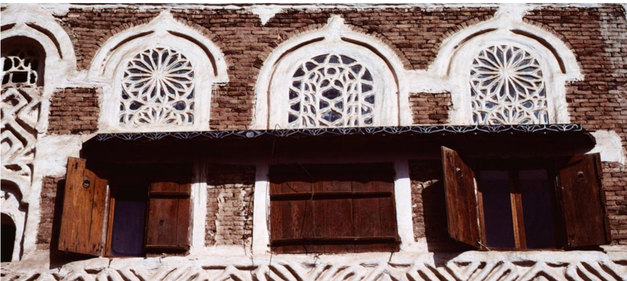
Abb. 22 Bei dieser Fassade in der eng verbauten Innenstadt sind sowohl die Oberlichtgitter wie auch die Mauerpartien variantenreich gestaltet. Die zwei hölzernen Erker ermöglichen Frauen unerkannt ohne Schleier nach unten zu sehen.
