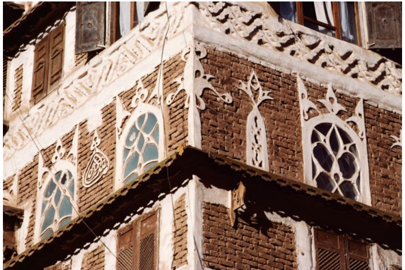
Abb. 24 Bei diesem Haus ist in den Mauerdekor auch eine längere arabische Inschrift eingearbeitet. Beim rechten Fenster sieht man deutlich die Unterschiede in den äußeren und den inneren Gittern des Oberlichts.
