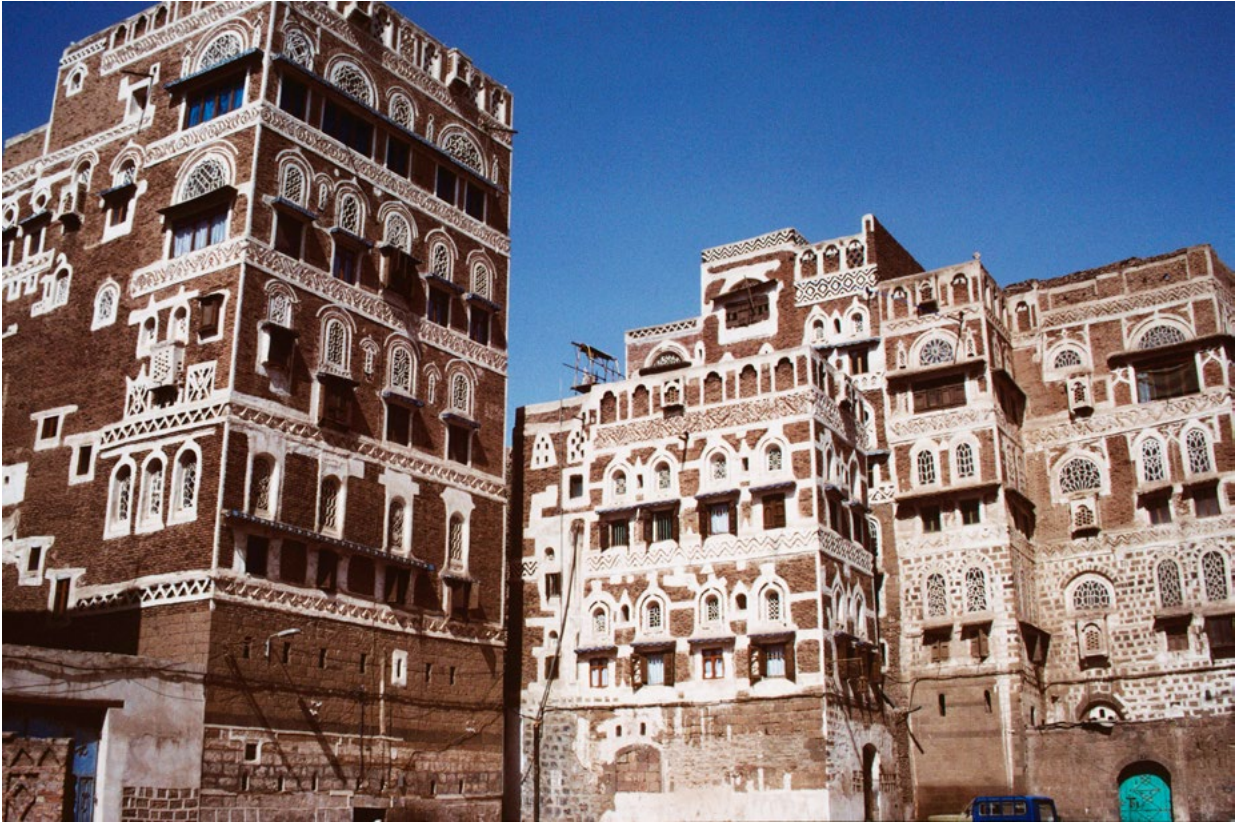
Abb. 12 In dieser Fassade finden sich in den Oberlichtfenstern gleich acht Rundfenster. Bei den oberen gibt es bereits Gitter, bei den unteren dürfte es sich bei drei der Verschlüsse um dünne Alabasterscheiben handeln, eine frühe Form des transluzenten Verschlusses.
