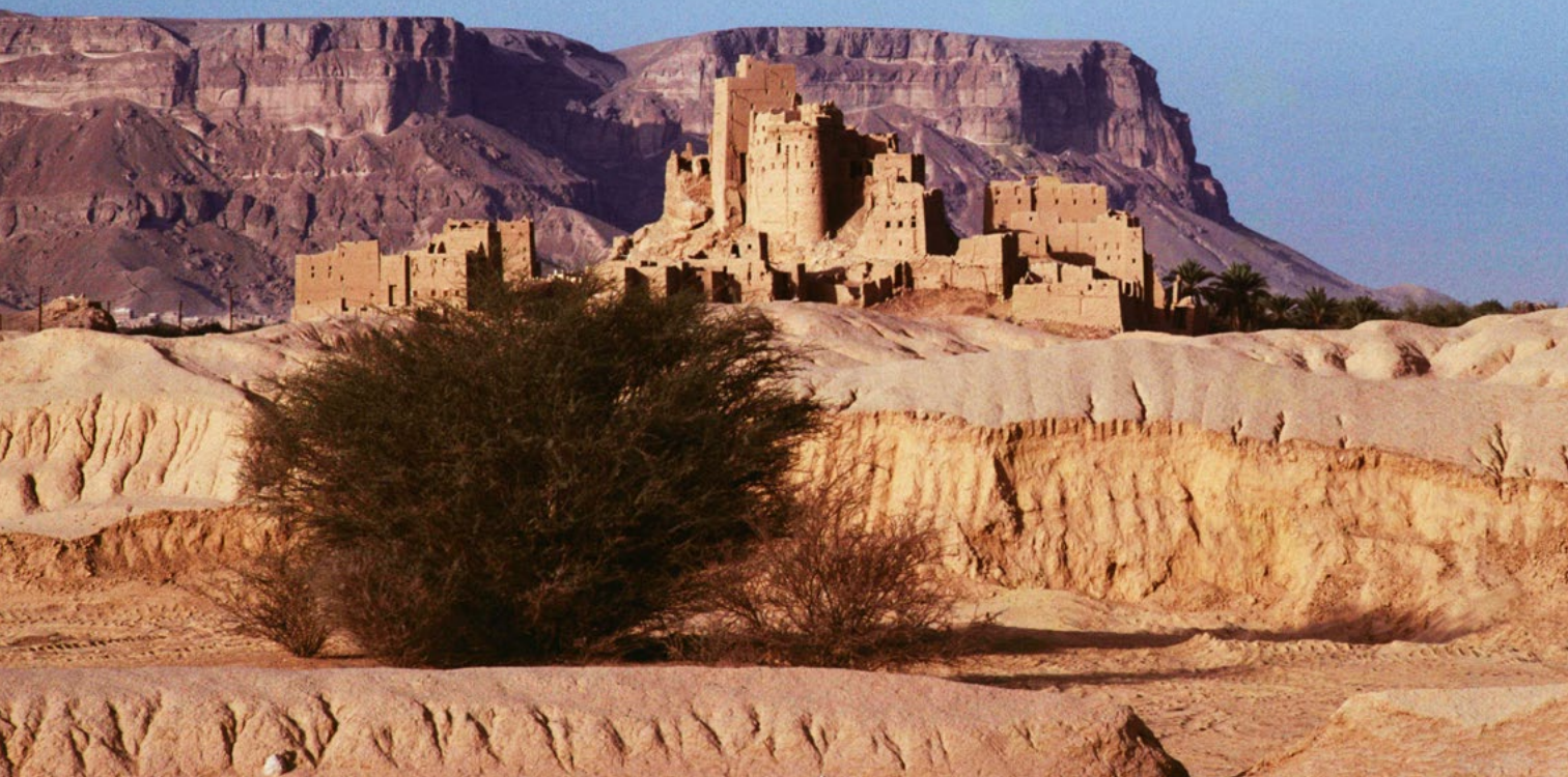
Abb. 135 Diese Agglomeration von zerfallenden Lehmbauten demonstriert gut, was nach einigen hundert Jahren aus verlassenen Bauten wird – sie werden zu dem, was sie einmal waren und lassen sich in dem zugehörigen Lehmhügel am Ende nur noch archäologisch nachweisen.
