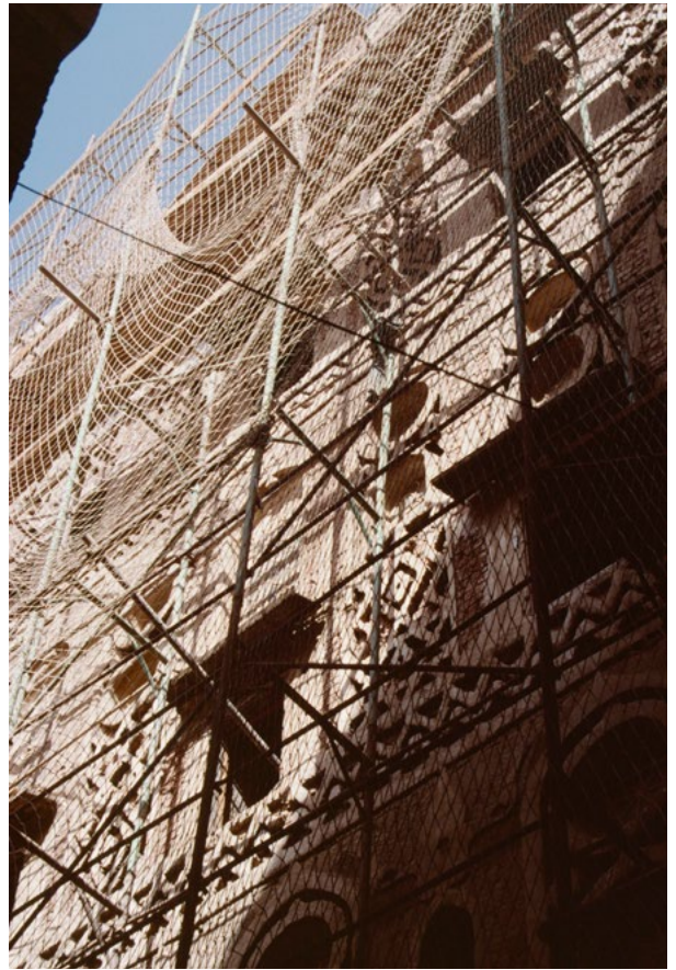
Abb. 19 Sanierung einer Fassade mit sehr vielen Rundfenstern.
