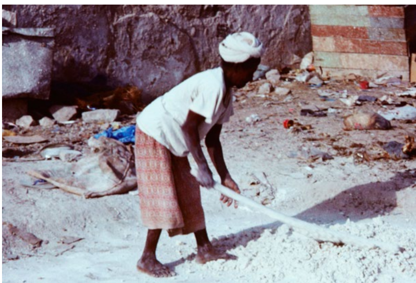
Abb. 170 Hier wird in Al Mukalla gebrannter Kalk zerschlagen und dann eingesumpft. Foto: Adele Drexler
