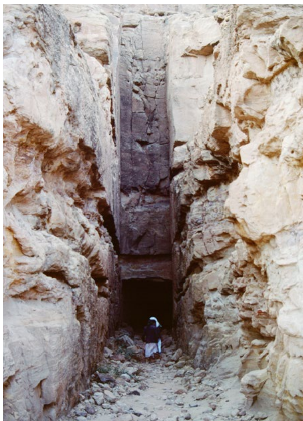
Abb. 298 Der vier Meter breite und gleich hohe Zulauf in den Tunnel. Eine antike Inschrift über dem Einlaufportal und an den zwei Seiten gibt Auskunft über die Errichtung des Tunnels.
