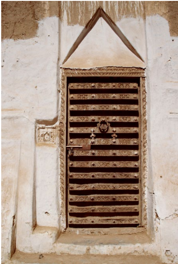
Abb. 122 Traditionelle Holztür ohne Holzschloss und mit einem zurücktretenden dreieckigen Feld über der Tür. Das Türchen an der Seite erlaubt dem Besucher per Seilzug in allen Stockwerken des Hochhauses kleine Glocken zu läuten und sich so bemerkbar zu machen.
