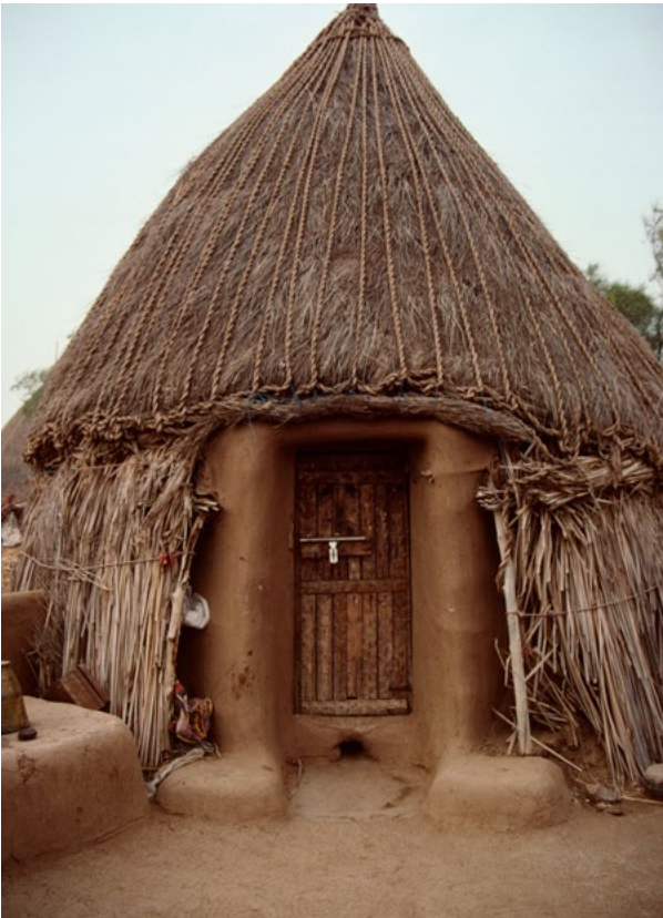
Abb. 255 Auch die Hütte meines Gastgebers war von dessen Mutter erbaut worden. Die über das Dach gespannten Seile sollen helfen, bei heftigen Wüstenstürmen die Deckung und den Regenschutz festzuhalten.
