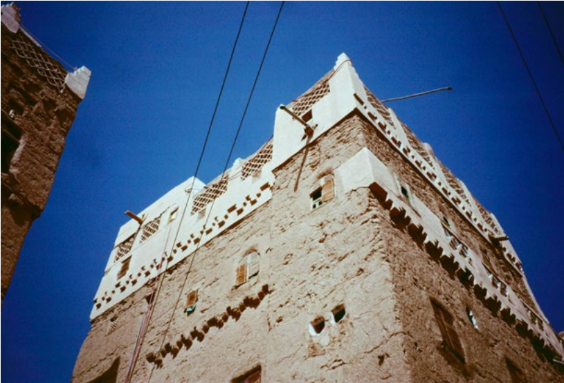
Abb. 151 Viele Häuser in Sif zeigen leichte Auskragungen in den Obergeschoßen. Sie verleihen der Architektur einen eigenen Charakter.
