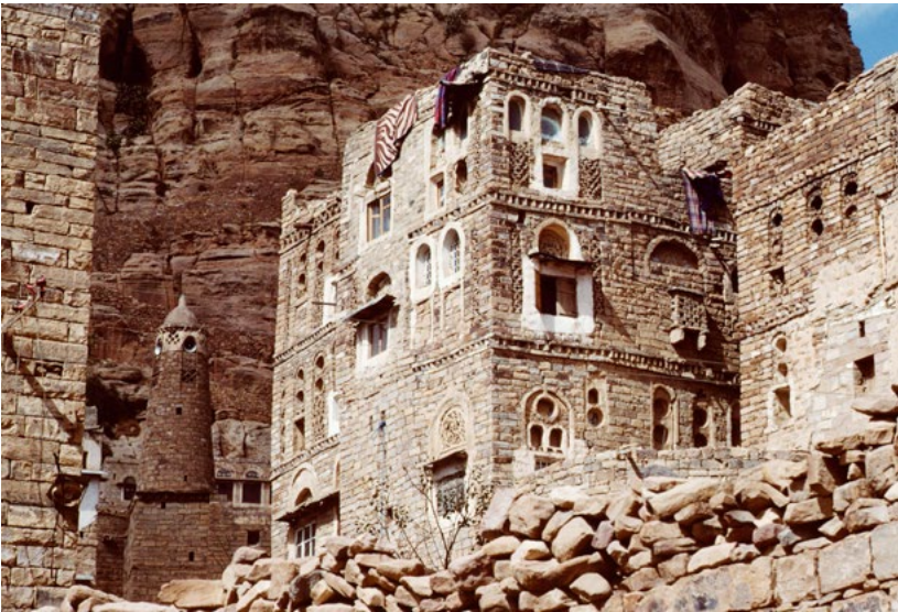
Abb. 238 In Thulla ist fast alles aus Stein gebaut, Erker, Ornamente und auch die "Kragkonstruktionen" in den Fassaden, die hier nur Dekor sind und keine statische Funktion haben können.
