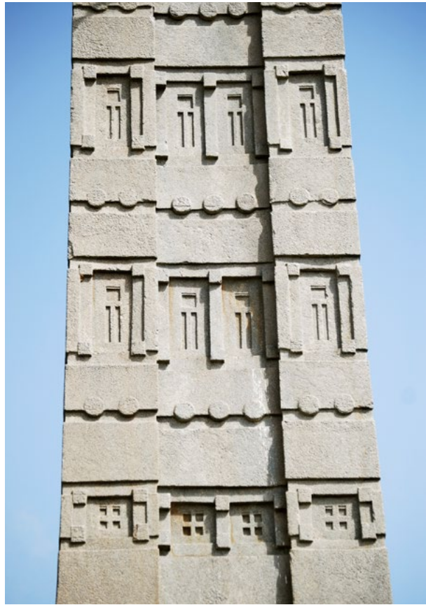
Abb. 318 Das erste Obergeschoß und zwei Regelgeschoße der Stele 3. Nur zwischen den Fenstern gibt es auch vertikale tragende Holzstützen. Man sieht die runden Geschoßdeckenbalken rhythmisch vortreten.
