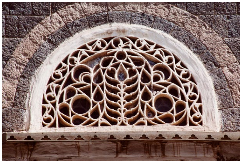
Abb. 41 Bei diesem Oberlichtgitter schimmert das innere Gitter, das eine andere Form hat, durch die Verglasung des äußeren Gitters.
