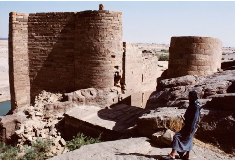
Abb. 49 Blick von Südwesten in die "Südschleuse".
