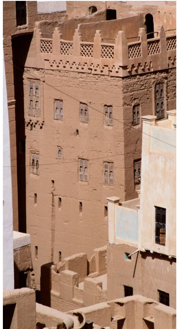
Abb. 154 Dieses Eckhaus in Sif zeigt die für das Wadi Duan charakteristischen Auskragungen der vortretenden Geschoße mit den T-förmigen Unterstützungen. Da die Auskragungen hier in beiden Richtungen in einer Ebene liegen, dürfte hier nur eine Balkenlage durchlaufen und vorkragen, während die zweite Lage nur mit dem ersten inneren Balken, der parallel zur Innenwand liegt, verklintet ist. Ganz links oben sieht man einen Übergang von einem Haus zum nächsten auf der Ebene des sechsten Stockwerks.
