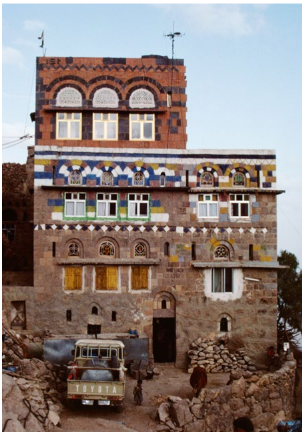
Abb. 223 Farbig gestaltetes Haus unterhalb von Schahara. Die Farbigkeit wird durch verschiedenfarbiges Natursteinmaterial und durch das Auftragen von Farbe auf einzelne Steine erzielt.
