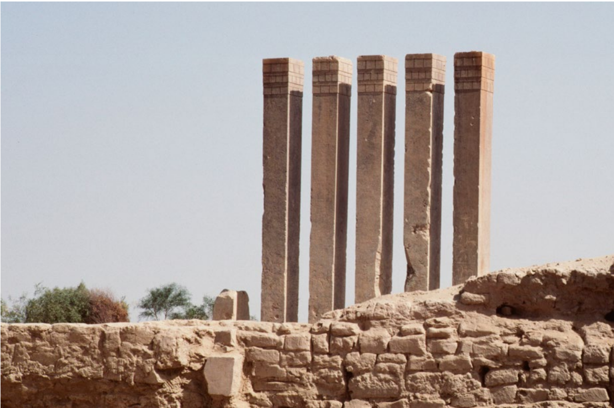
Abb. 56 Fünf der ursprünglich sechs rund 6 m hohen Pfeiler des Portikus am "Mondtempel" in Marib. Die Pfeiler zeigen am oberen Ende je ein als Flachrelief dargestelltes Pfeilerkapitell.
