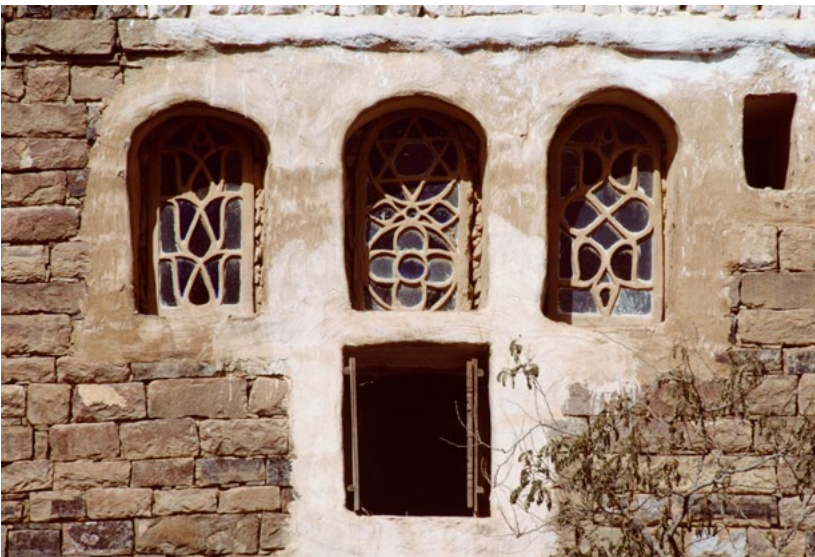
Abb. 239 Bei diesen drei Oberlichtern eines Fensters in Thulla existieren nur die inneren Gitter mit ihren farbigen Verglasungen. Auf die äußeren wurde wohl verzichtet.
