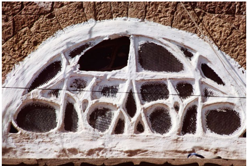
Abb. 25 Bei diesem Außengitter eines Oberlichts erkennt man gut die unterschiedlichen Pressgläser der Gitterverglasung mit Weißglas.
