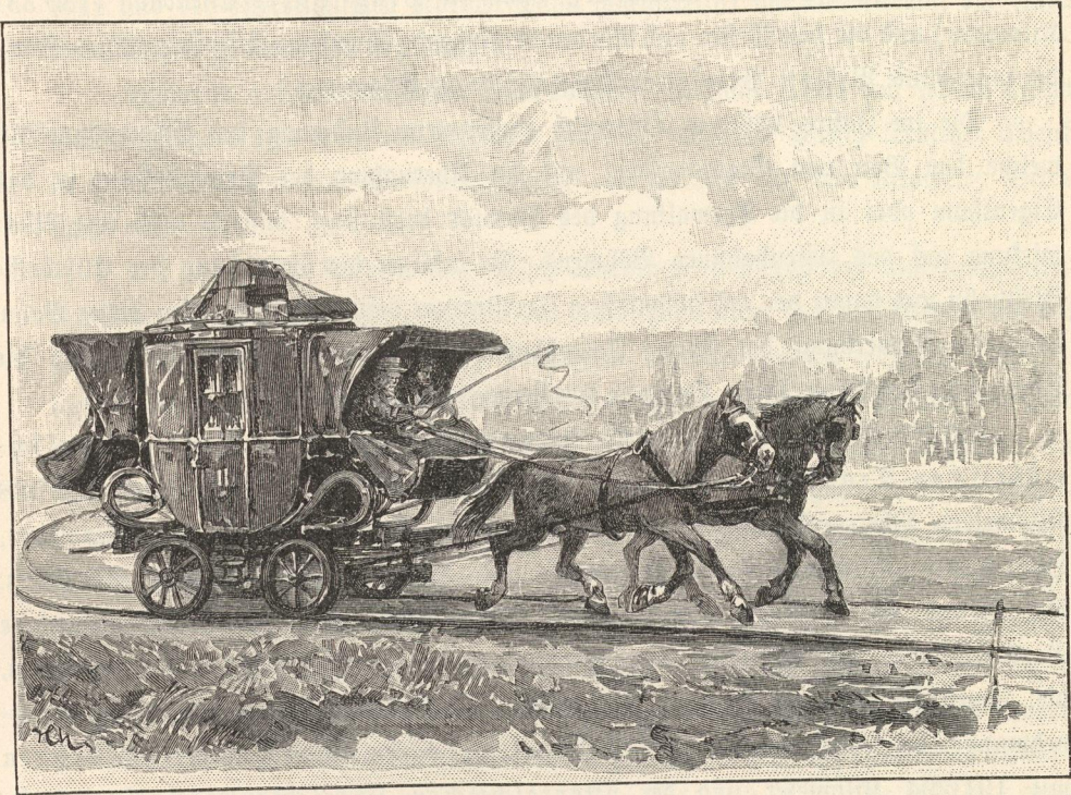
Die alte Budweis-Linzer Eisenbahn.
