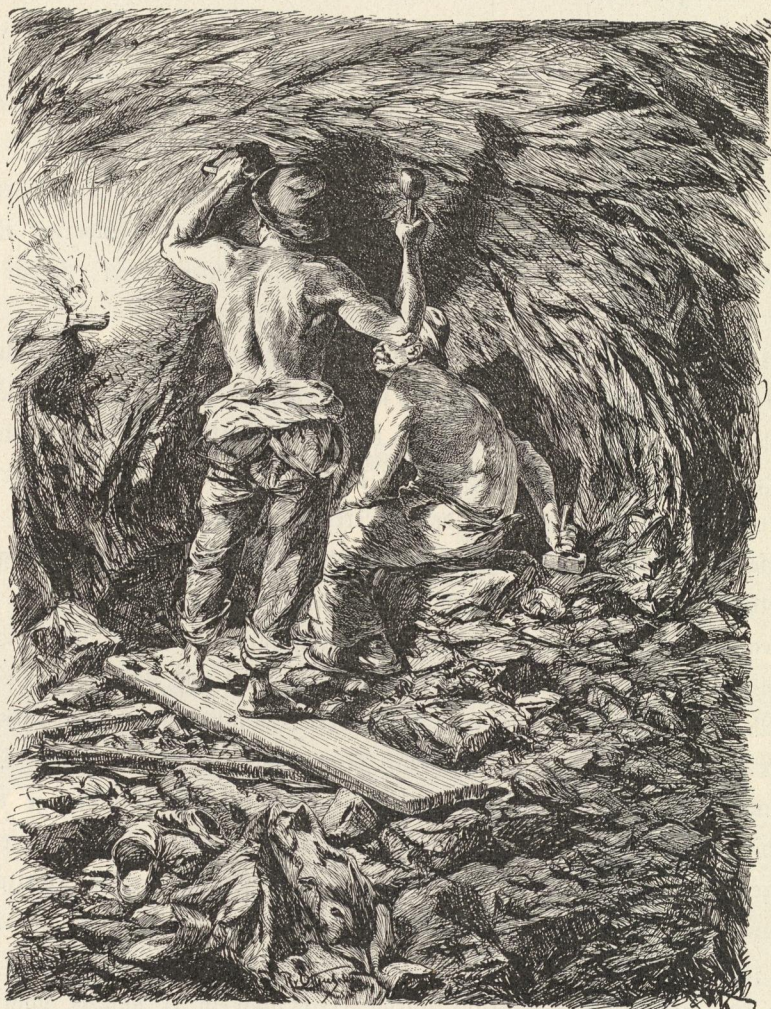
Montanwerk in Příbram: Arbeit in der Grube.
