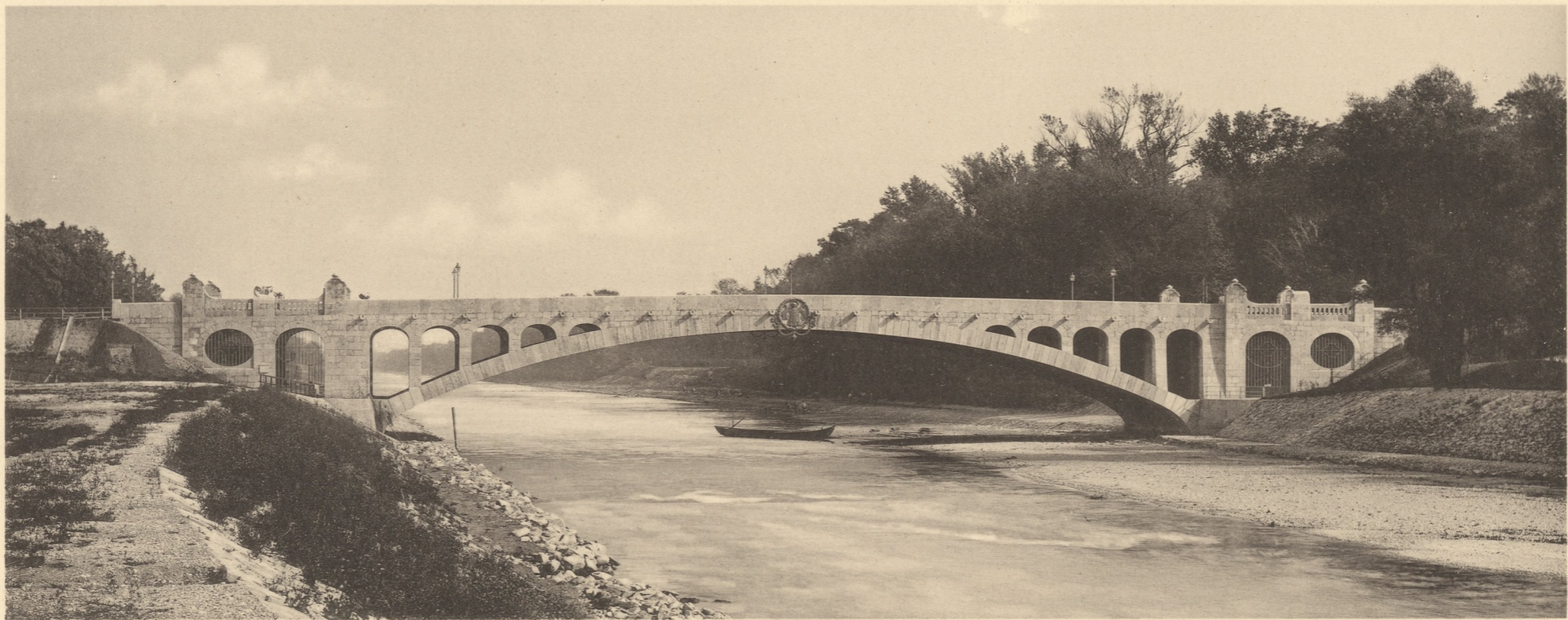
Prinz-Regenten-Brücke. Erbaut 1901. Max Josef-Brücke. Erbaut 1900—02.
