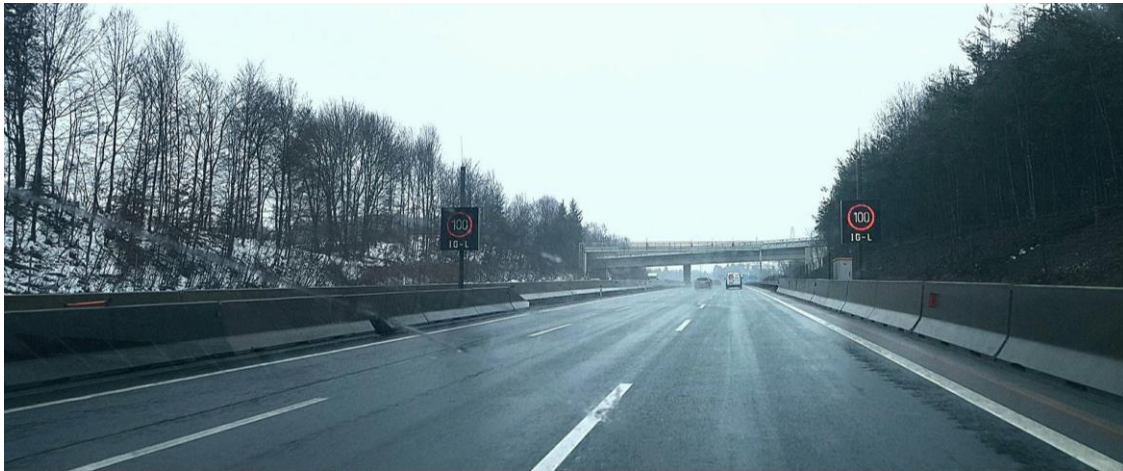
Abbildung 29: Autobahn A2 Fahrtrichtung Graz im Bereich der Raststation Arnwiesen, Steigungsstrecke mit drei Fahrstreifen ohne Pannestreifen
