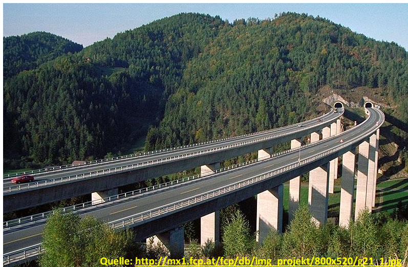
Abbildung 33: Brücke G21 auf der Autobahn A2 Nähe der Anschlussstelle St. Andrä
