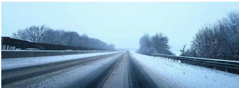
Abbildung 26: Autobahn A9 bei winterlichen Fahrverhältnissen im Bereich der Anschlussstelle Wildon mit normalbreiten Pannestreifen
