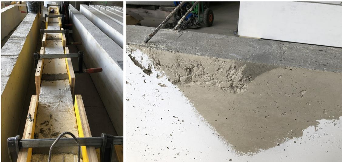
(a) Verfüllen des Vergussmörtels
