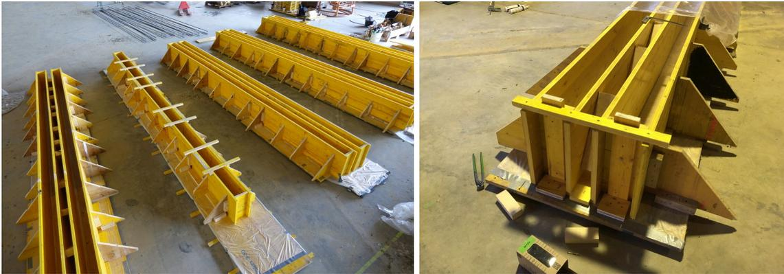
Abb. 4.4.: Leere Schalungskonstruktion
