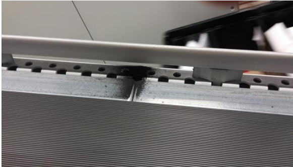
Bild 4-16: Abrieb des Förderbandes an einem Stoß in der Abstützung
