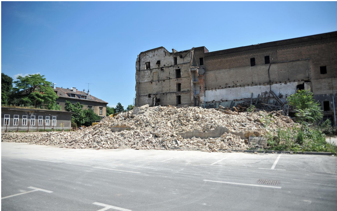
Abb. 40: Der ruinierte Komplex Paromlin Abrissarbeiten von Paromlin, Večernji list, 2014
