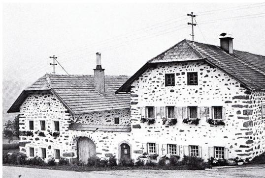
Abb.: 53 | Steinbloss-Mauern, Rohrbach/Reichenau, Luger 1981, 139
