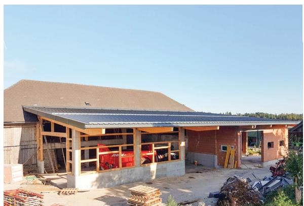
Abb.: 117 | 1. Reihe: Anbau Stall mit Betondecke, betonieren Boden
