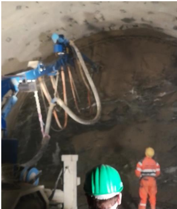
Abbildung 1: Auftrag von Nassspritzbeton mit einer Spritzmaschine auf der Tunnellaibung
