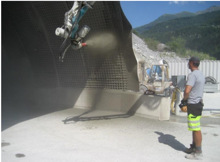
Abbildung 43: Spritzvorgang im Versuchsstollen (Röck u. a., 2017)
