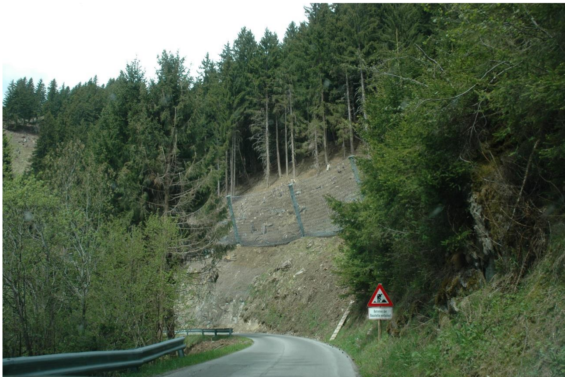
Abbildung 16: Errichteter Schutzzaun entlang der Straße (Bild: Ramic & Weiss 2017)
