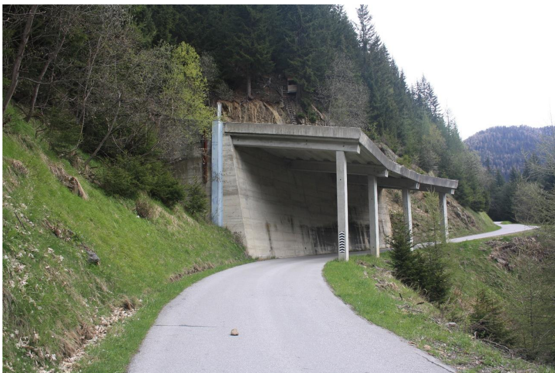
Abbildung 13: Sicherheitsbaumaßnahme entlang der Astenstraße, östlich des Mörtlachbergs (Bild: Liu 2016)
