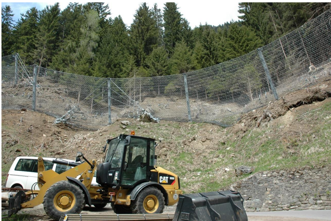
Abbildung 17: Schutzzaun (Bild: Ramic & Weiss 2017)
