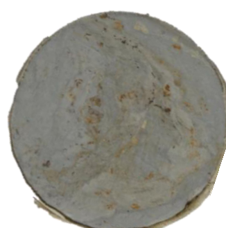
Kernbohrung KB1 Tiefe 6,1 m
