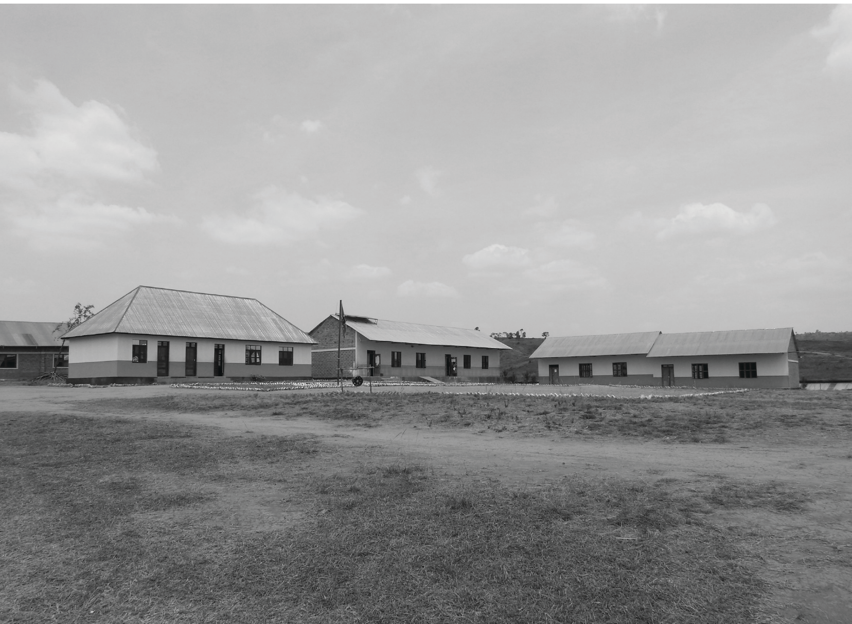
Abb. 24: Bauplatz; Blick Richtung Südwesten
