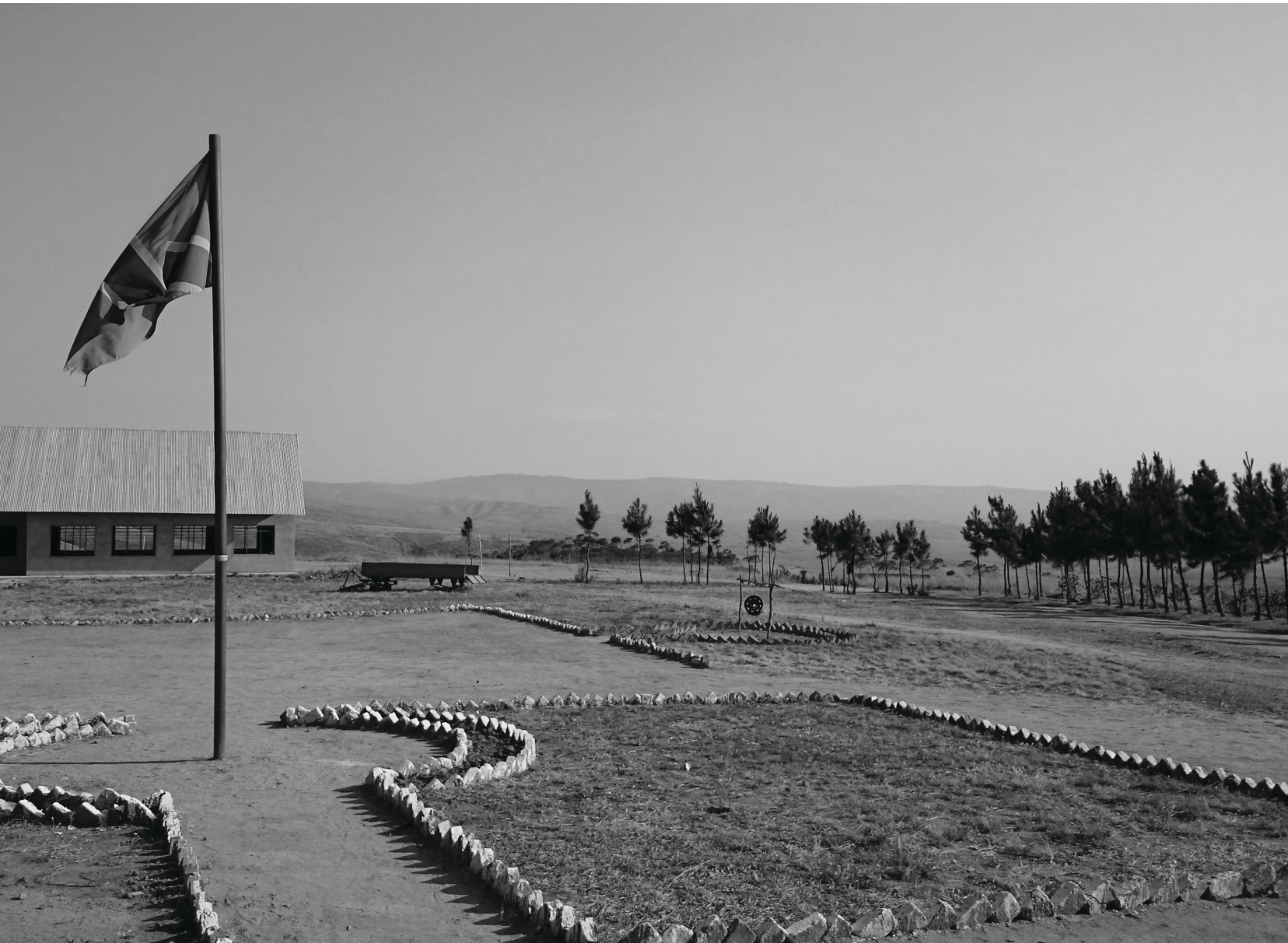
Abb. 23: Bauplatz; Blick Richtung Norden
