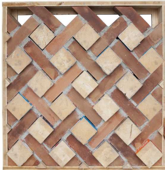
Abb. 42: Ziegelgitter 1 : 1 mit Schablonen
