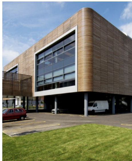
Abb. 74: Sunny Studio Holzfassade2
