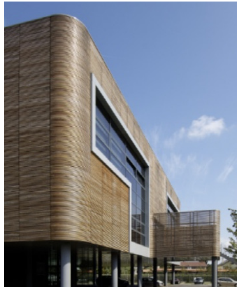
Abb. 72: Sunny Studio Holzfassade
