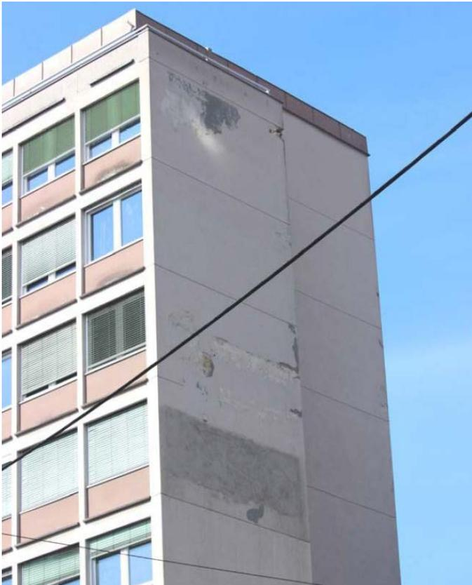
Abb.84. Fassade Betonabplatzungen
