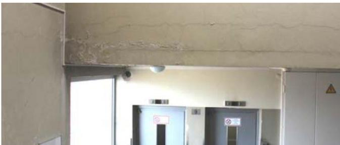
Abb.77. Wasserschaden Stiegenhaus
