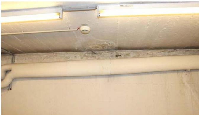
Abb.79. Wasserschaden Decke KG
