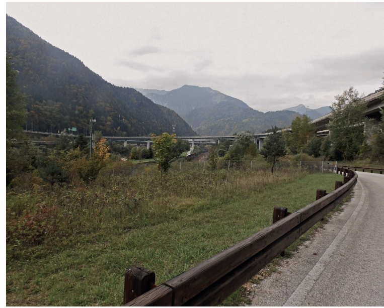
Infrastrukturknoten bei Pontebba
