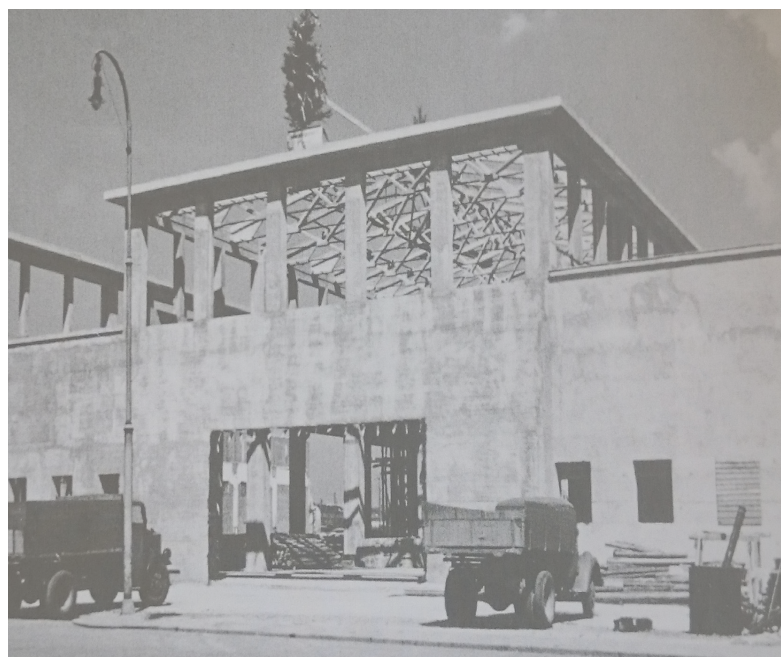
Abb.59 unten: Die wiederaufgebaute Halle 2 mit Flachdach.
