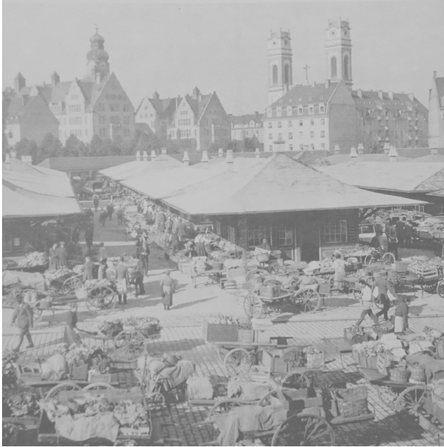
Abb.54 unten: Das Areal der heutigen Gärtnerhalle, mit pavillionartigen Verkaufsbuden. Im Hintergrund die eingeschossige Sortieranlage. Mit dem Bau der Gärtnerhalle in den 60ern wurde die Idee des offenen Marktes verworfen
