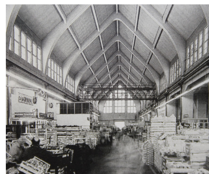
Abb.51 unten: Die Eisenbetonrippen in der Innenansicht.
