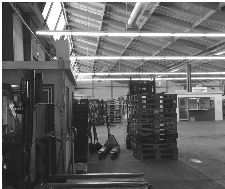
Abb.71 oben: Die Innenansicht der Gärtnerhalle mit ablesbarer Sheddachkonstruktion
