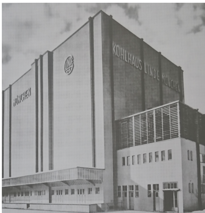
Abb.58 oben: Das Kühlhaus Linde
