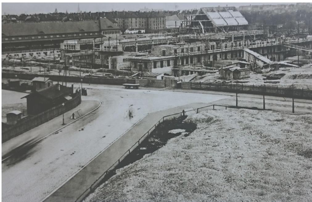
Abb.28 unten: die Bauarbeiten zur Großmarkthalle
