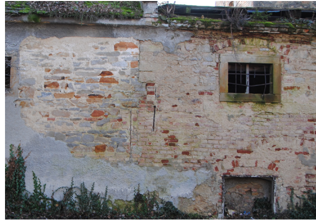
Abb. 90. Nordfassade des Nordtrakts, Baufuge
