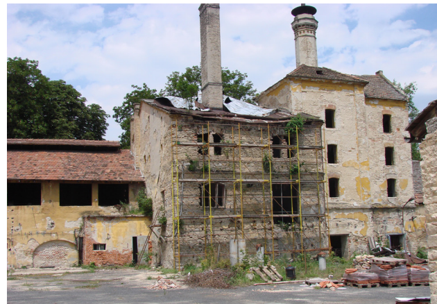
Abb. 124. Bauzeitliche Stehfalzdeckung über dem ehemaligen Sudhaus (2008)
