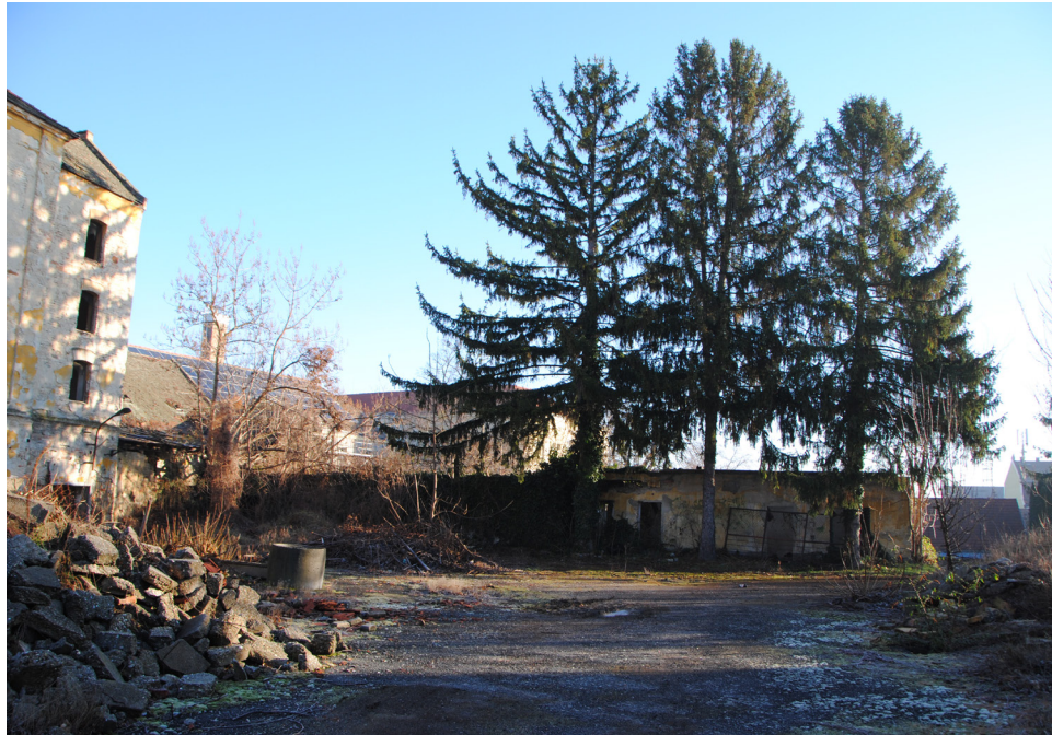
Abb. 47. Westfassade des Osttrakts
