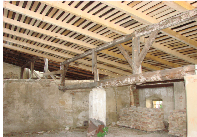
Abb. 123. Provisorisches Schutzdach über dem Raum 1.04 (2008)
