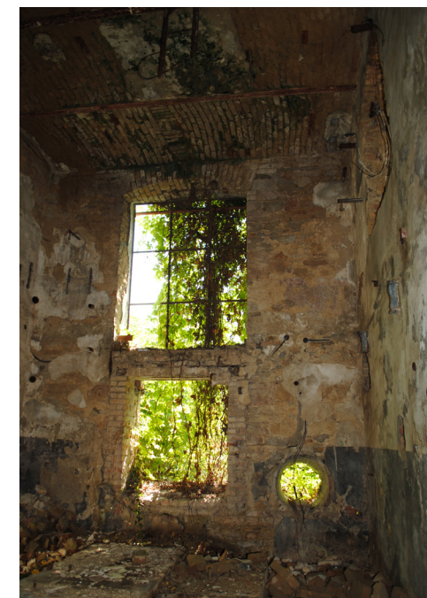
Raum 0.28, Nordtrakt, ehemaliges Sudhaus
