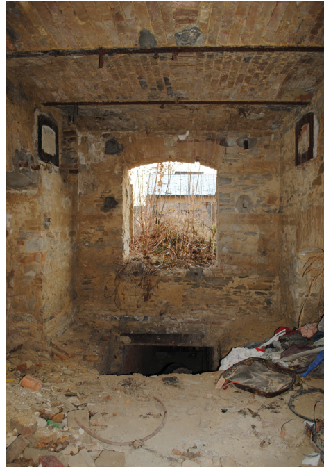
Raum 0.27, Nordtrakt, ehemaliger Maschinenraum/Kesselraum
