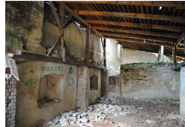
Raum 1.04, Nordtrakt, ehemalige Malztenne
