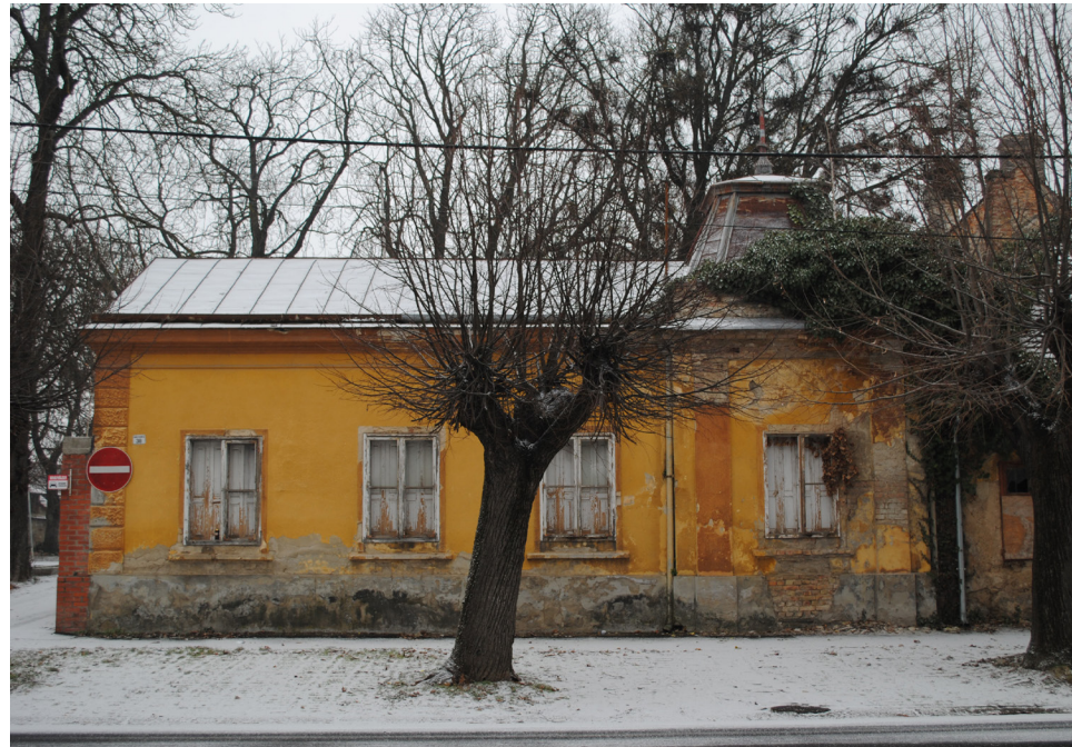
Abb. 39. Das ehemalige Ausschanksgebäude nördlich der Brauerei (Deák-Ferenc-Straße)
