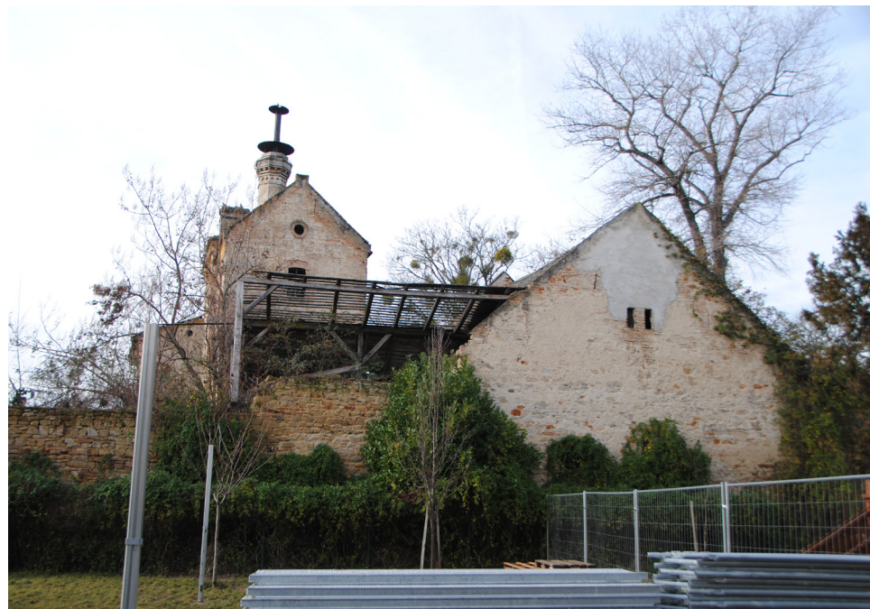
Abb. 42. Östliche Grundstücksgrenze, Ostfassade des Nordtrakts
