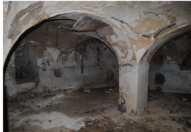
Raum 0.23, Nordtrakt, ehemalige Malztenne
