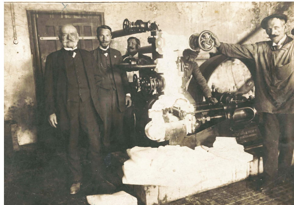
Abb. 19. Brauerei Reischl, Maschinenraum (1915)
