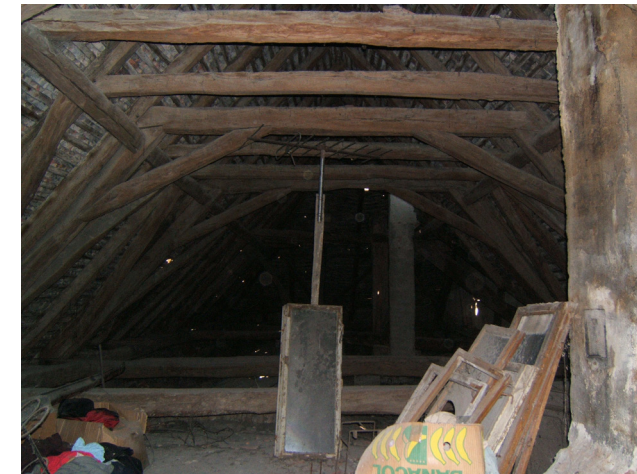
Abb. 71. Liegender Dachstuhl im Westtrakt (Raum 1.01)
