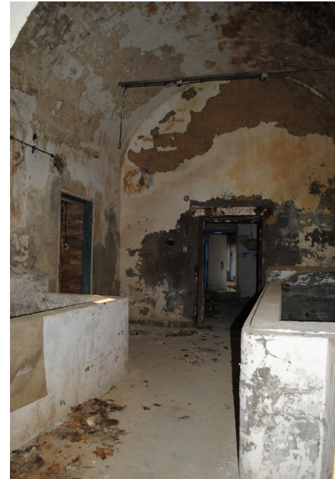
Raum 0.22, Nordtrakt, ehemalige Gerstenweiche
