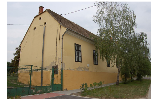
Abb. 61. Die ehem. Brauerei in Dad
