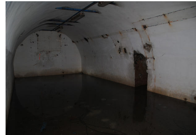
Raum -1.10, ehemalige Kelleranlage
