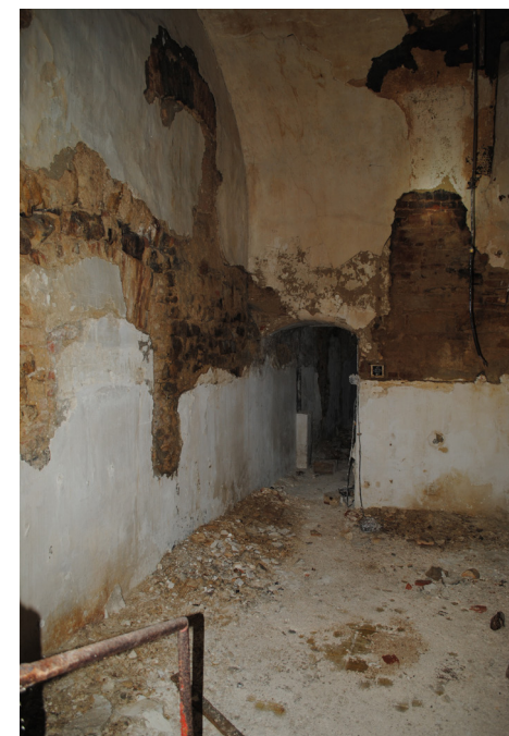
Raum 0.19, Nordtrakt, Raum des ehemaligen niederländischen Ofens
