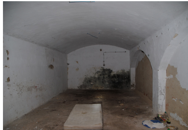
Raum 0.25, Nordtrakt, ehemalige Malztenne
