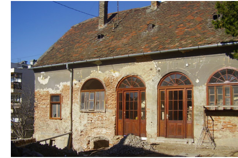
Abb. 57. Die ehem. Brauerei in Vasvár
