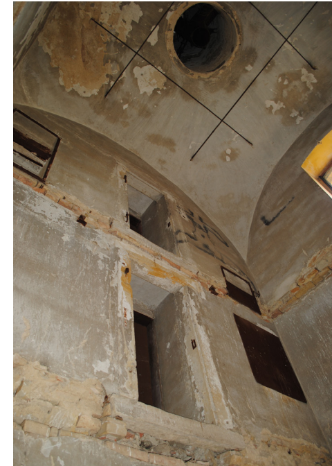
Raum 1.07, Nordtrakt, ehemalige Darre
