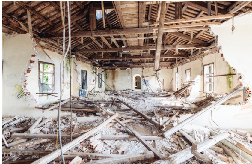
Haus A, Stiegenhaus (o.) Haus A, 1. Obergeschoss Blickrichtung Osten (u.)
