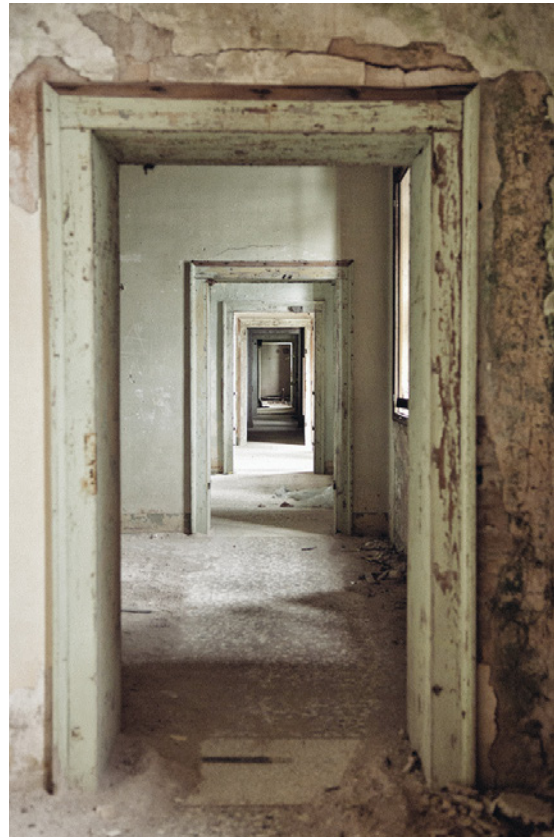
Haus A, Stiegenhaus 1. /2. Obergeschoss (l.) Haus A, Zimmerschließung (r.)
