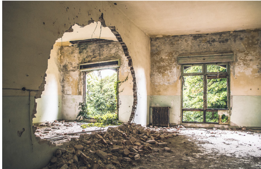
Haus C, Erdgeschoss (o.) Haus C, 1. Obergeschoss Blickrichtung Westen (u.)
