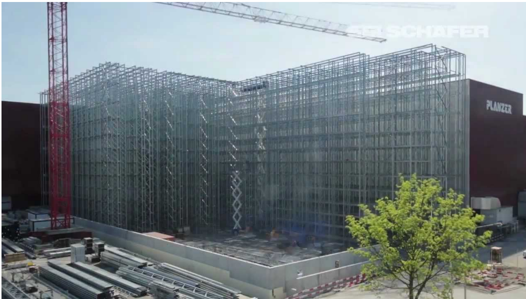
Abbildung 2-3: Hochregallager im Bauzustand (Quelle: SSI Schäfer)
