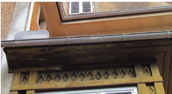
Abb. 62: Top 2, Veranda Dachuntersicht
