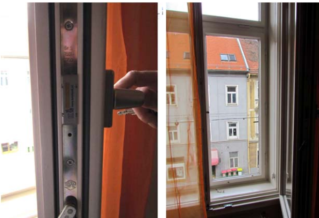
Abb. 64: Top 3, Kastenfenster mit Holzfenster innen (neuwertig) und Holzfenster außen (Altbestand)
