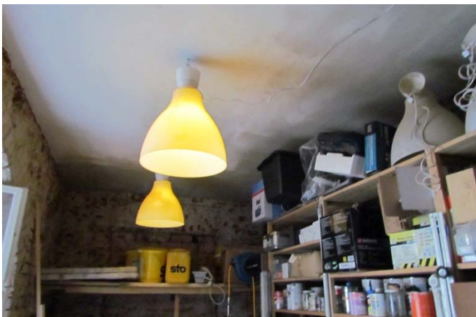
Abb. 44: Lagerräume I – Decke
