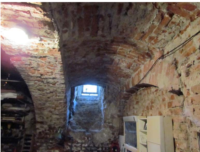
Abb. 48: Lagerraum II – Decke u. Wände
