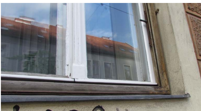
Abb. 51: Top 1, Kastenfenster mit Rollladen, außen
