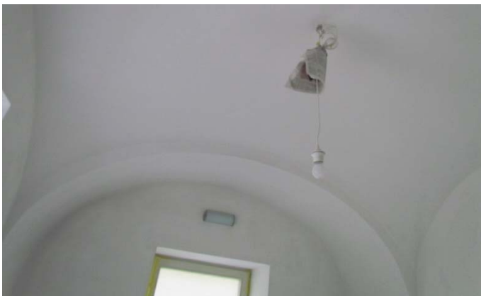
Abb. 57: Top 2, Räume mit Gewölbedecke
