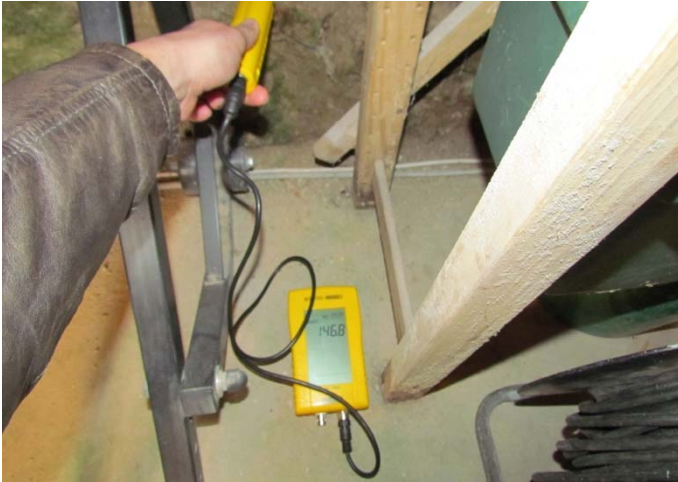
Abb. 46: Lagerräume I – Feuchtemessung
