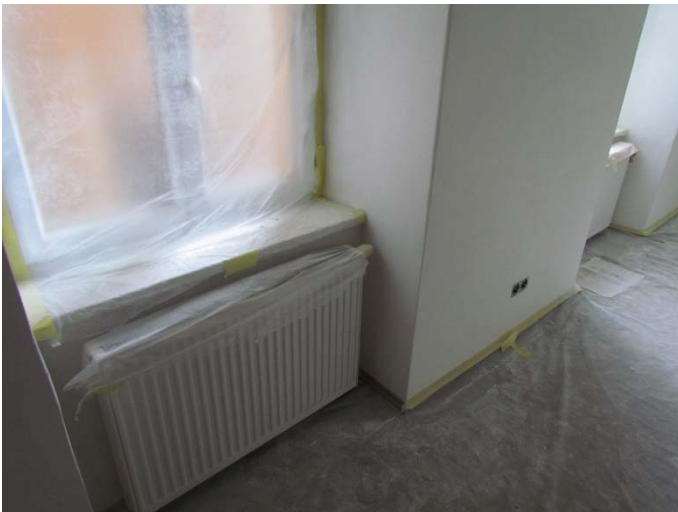
Abb. 59: Top 2, Zimmer, Malerarbeiten im Gange
