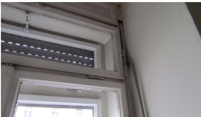
Abb. 50: Top 1, Kastenfenster mit Rollladen, innen
