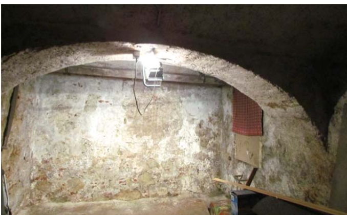
Abb. 42: Keller – Decke und Wände
