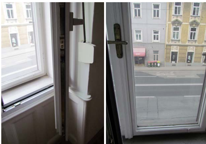
Abb. 56: Top 2, Kastenfenster mit Kunststofffenster innen (neuwertig) und Holzfenster außen (Altbestand)
