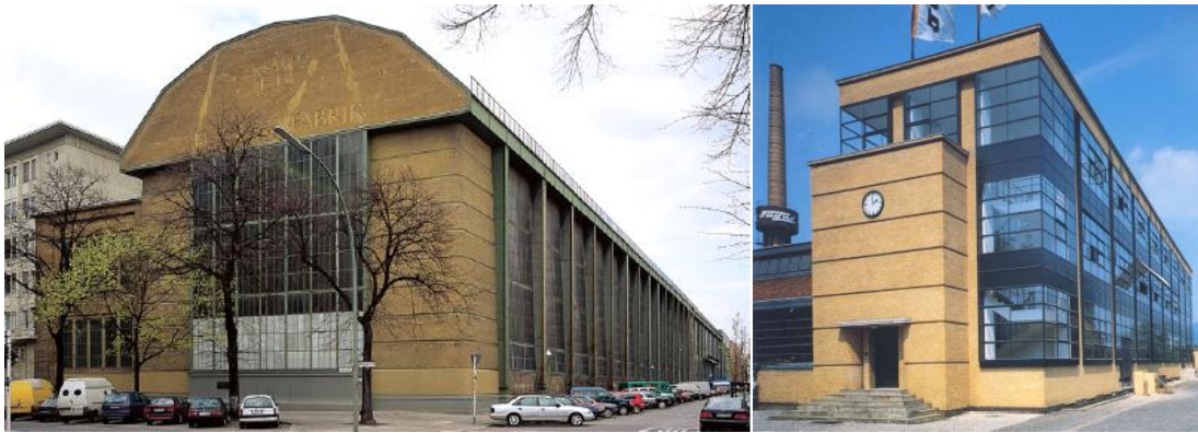
Abbildung 2-4-1: AEG-Turbinenfabrik (links) [34] und die Faguswerke (rechts) [33]
