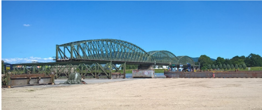
Abbildung 1-2: Abriss der Linzer Eisenbahnbrücke über die Donau, Juni 2016
