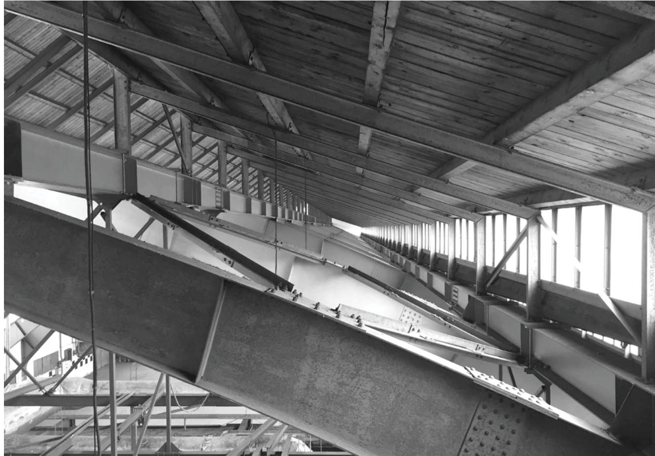
links: Wiederaufbau der Halle in Stahlbauweise (Foto: Archiv der Stadt Linz)
