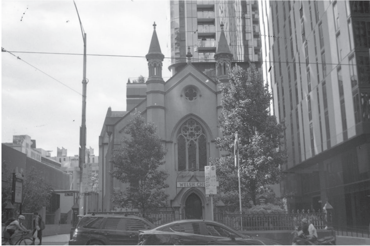
Abb. 6. 320 Latrobe Street Melbourne, Melbourne City Die kleine Struktur in Mitten von Hochhäusern. Gebäudehöhen sprünge - in Melbourne keine Seltenheit.
