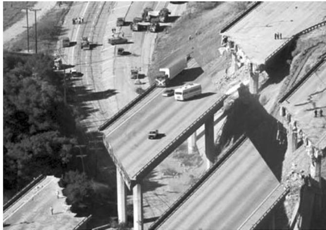
Abbildung 1: Brückeneinsturz in Northbridge 1994, USA [3]
