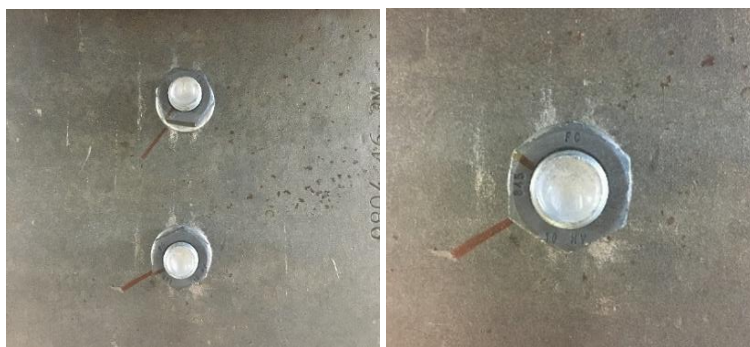
Abb. 2-16: Kombiniertes Vorspannverfahren – links vor, rechts nach dem Weiterdrehen
