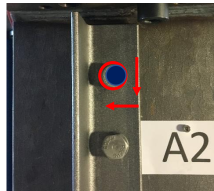
Abb. 4-5: Schematische Darstellung des Nachrutschens der Schrauben
