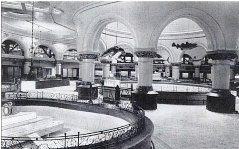
Abb. 38: Foto der Innenansicht
