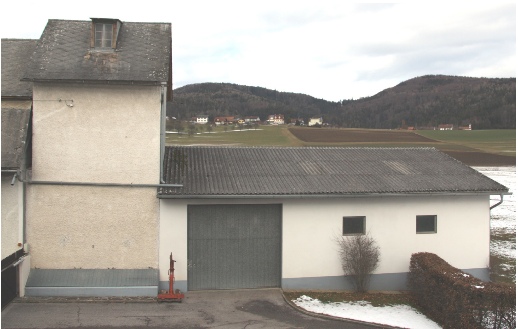
Abb. 44: Südansicht; Silo, Lagerhalle
