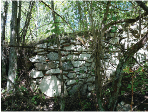
Abb.49: Haus Nr. 5: Nowotny (Gasthaus)
