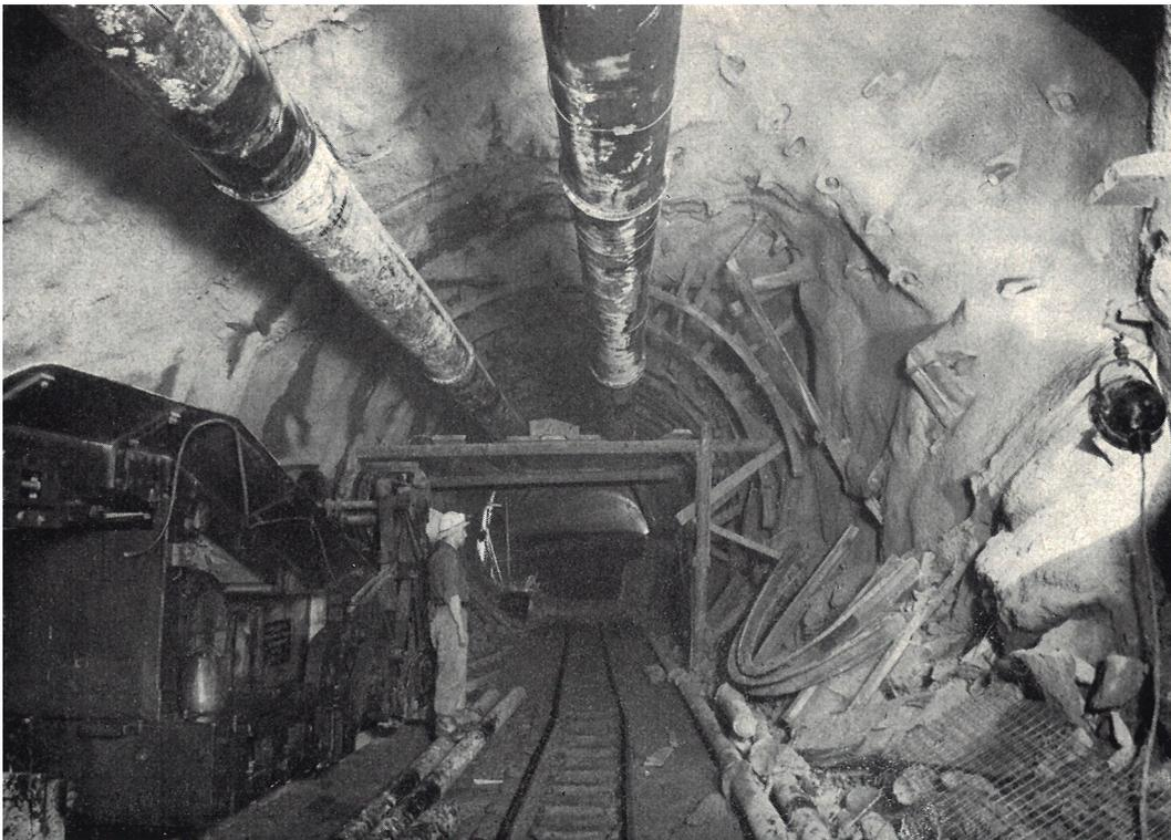
Abbildung 3.10: Spritzbetonsicherung des Druckstollen Prutz-Imst Baulos Runserau
