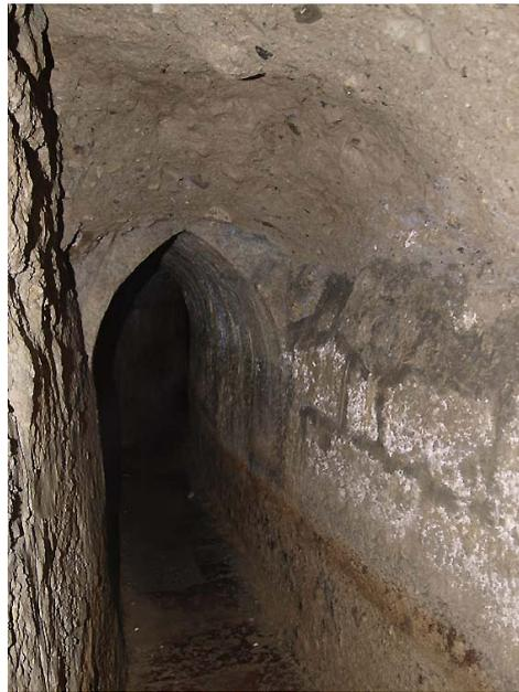
Abbildung 2.1: Stollenabschnitt mit unverbauter Firste - Mönchsberg
