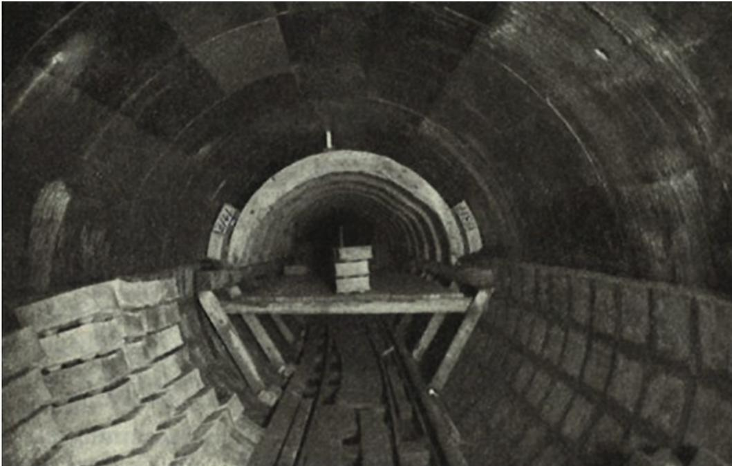
Abbildung 2.30: Mauerung des Gewölbes - Kernringstrecke Kops-Vallüla [24]
