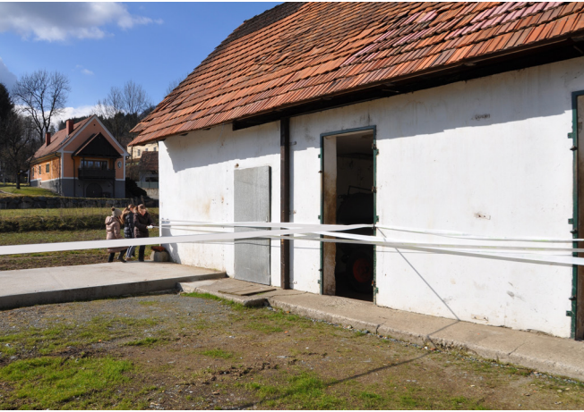
Abb. 33: Einwickeln des leerstehenden Nebengebäudes
