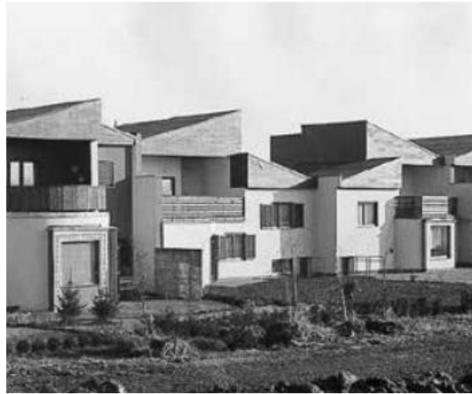
Abb. 14: Historische Aufnahme der Eschensiedlung
