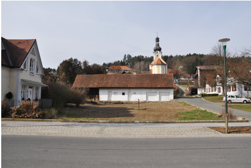
Abb. 70: Projektareal nach Phase I und nach dem Abriss des Wohngebäudes
