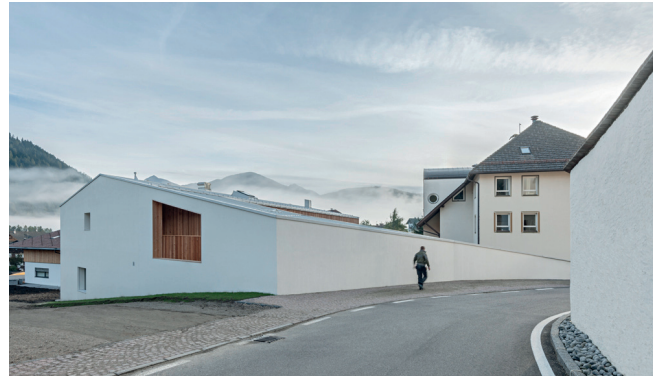
Abb. 98 Blick nach Osten
