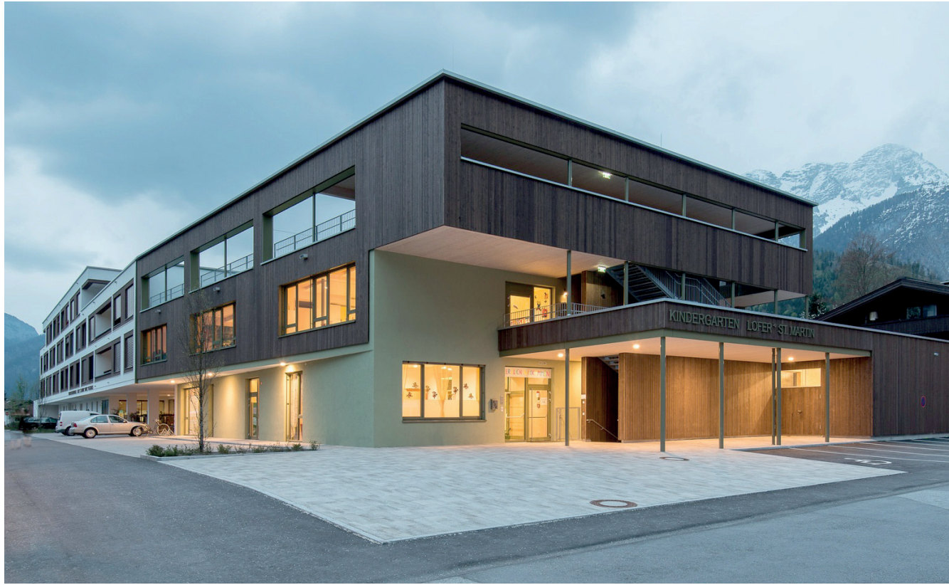
Abb. 43 Eingang Kindergarten (Nordseite)
