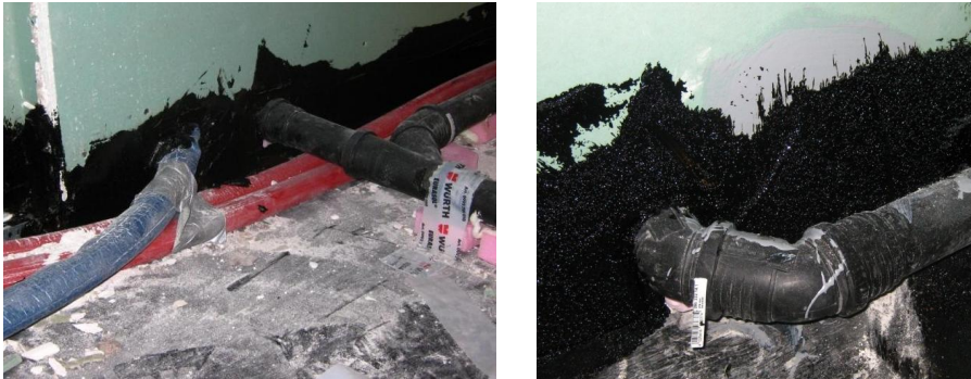
Bild 6.3 Durchdringung des Hochzugs der Sekundärabdichtung
