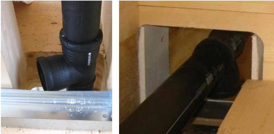
Bild 6.13 Schacht ohne Verkleidung der Leibung (links) und Schacht mit angebrachter Verkleidung (rechts)
