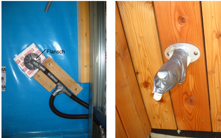
Bild 5.52 Anschluss der Außenarmatur mittels Dichtmanschette und Flansch (links) und fertig gestellte Außenarmatur im Terrassenbereich (rechts)
