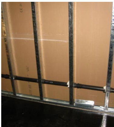
Bild 8.1 Leitungsführung in der Trockenbauwand zwischen Badezimmer und WC (links) und Vertikalschnitt der Durchdringung des Metallständers mit einem Abwasserrohr (rechts)
