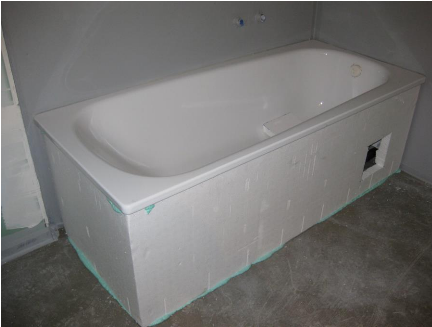
Bild 5.42 Wannenträger und Badewanne auf der Verbundabdichtung
