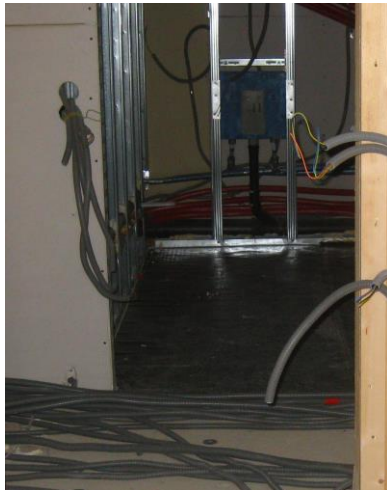
Bild 6.15 Verlegung der Sekundärabdichtung auf der Betondecke im Erdgeschoß
