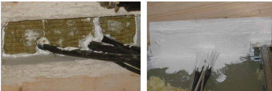
Bild 5.30 Weichschott (links) mit weißem, intumeszierenden Material (rechts)
