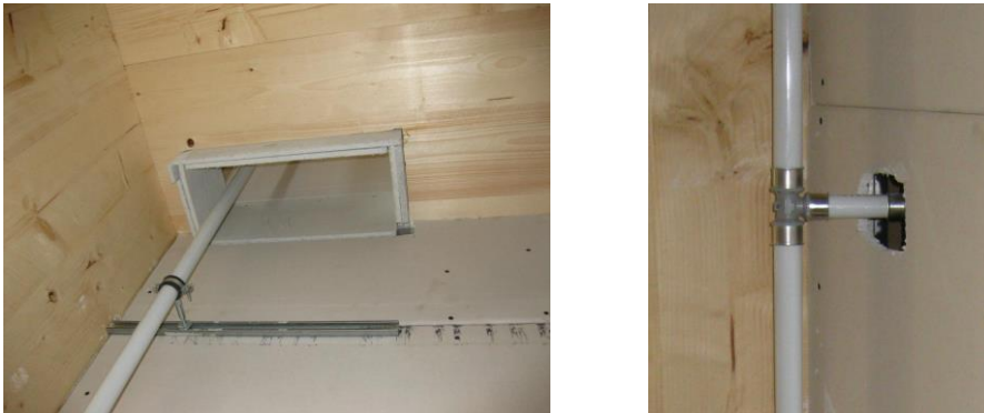
Bild 5.3 Befestigung der Leitungen (links) und Rohrverbindung mittels Pressfitting (rechts)
