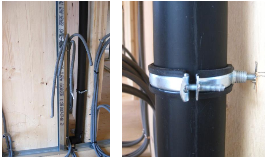
Bild 5.12 Fallleitung im Schacht der Küche (links) und Rohrbefestigung an der Holzmassivwand (rechts)
