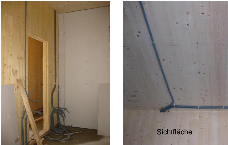
Bild 5.33 Leerverrohrung in Vorsatzschale (links) und an Sichtfläche (rechts)
