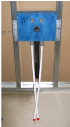
Bild 5.9 Sanitärelement zur Installation des Waschtisches
