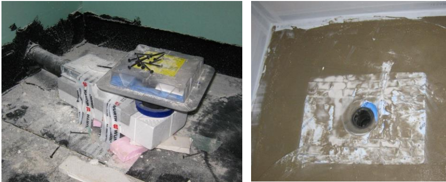
Bild 5.18 Duschbodenablauf (links) und Dichtmanschette (rechts)
