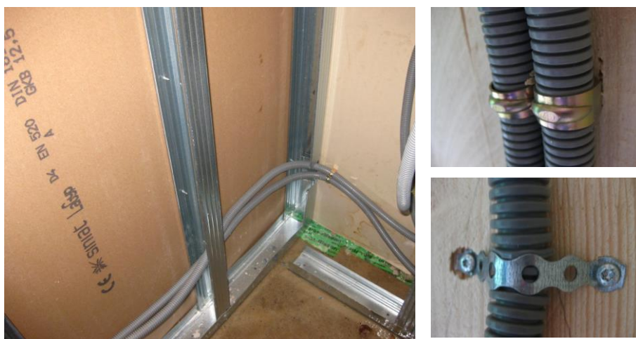
Bild 5.34 Leerverrohrung in Sanitärräumen (links) und Befestigung an Massivwänden mittels Einschlagklemmschelle (rechts oben) bzw. Lochband (rechts unten)
