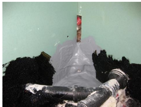
Bild 6.4 Entwässerungsschlauch in den Schacht im Eckbereich des Badezimmers
