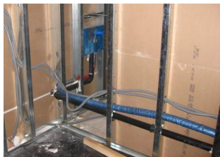
Bild 6.2 Leitungsführung in der Trockenbauwand
