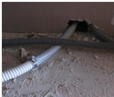
Bild 5.38 Befestigung mittels Klemmschelle an der Dichtmanschette
