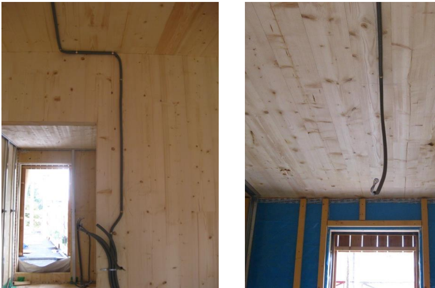
Bild 5.32 Leerverrohrung entlang der Wand für Schalter und Steckdosen (links) und an der Decke für Lichtauslässe (rechts)
