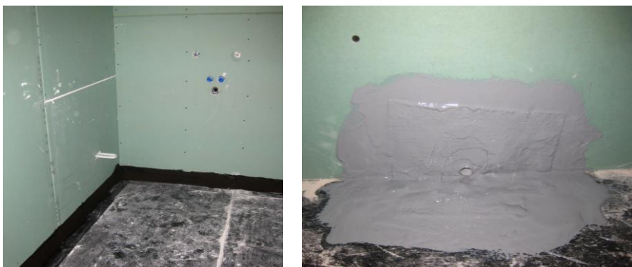
Bild 8.5 Ausführung der Sekundärabdichtung mit Hochzug an der Wand (links) und Entwässerung mit Hilfe eines Schlauchs (rechts)
