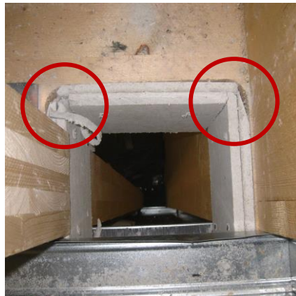
Bild 6.6 Runder Deckendurchbruch mit Verkleidung der Leibung aus GF-Platten
