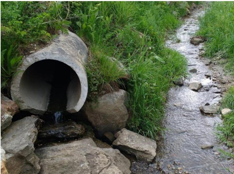
Abbildung 2-11: Auslass des NW-Kanals in den Stufenbach
