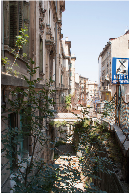
Abb. 81 - Brücken I Abb. 82 - Brücken II
