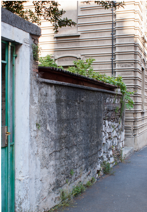
Abb. 77 - Mauern I Abb. 78 - Mauern II
