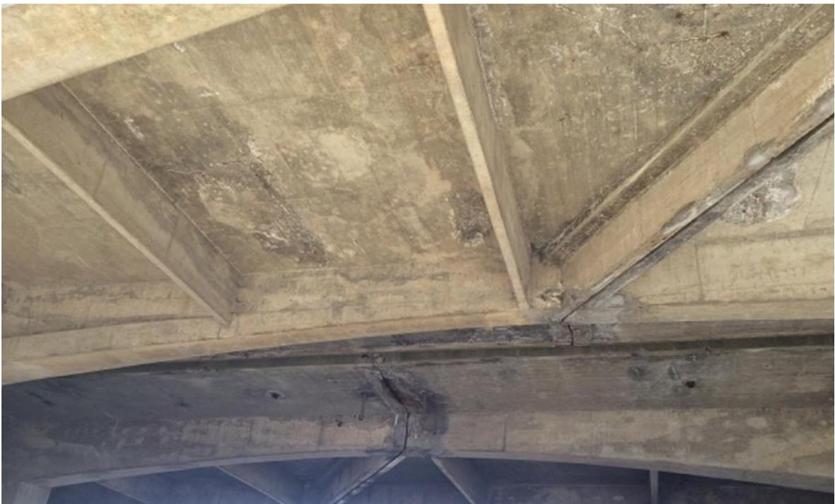
Abbildung 7: Detailansicht Gerbergelenk der Brücke über den Liebochbach vor Sanierung, (Moser, 2017)
