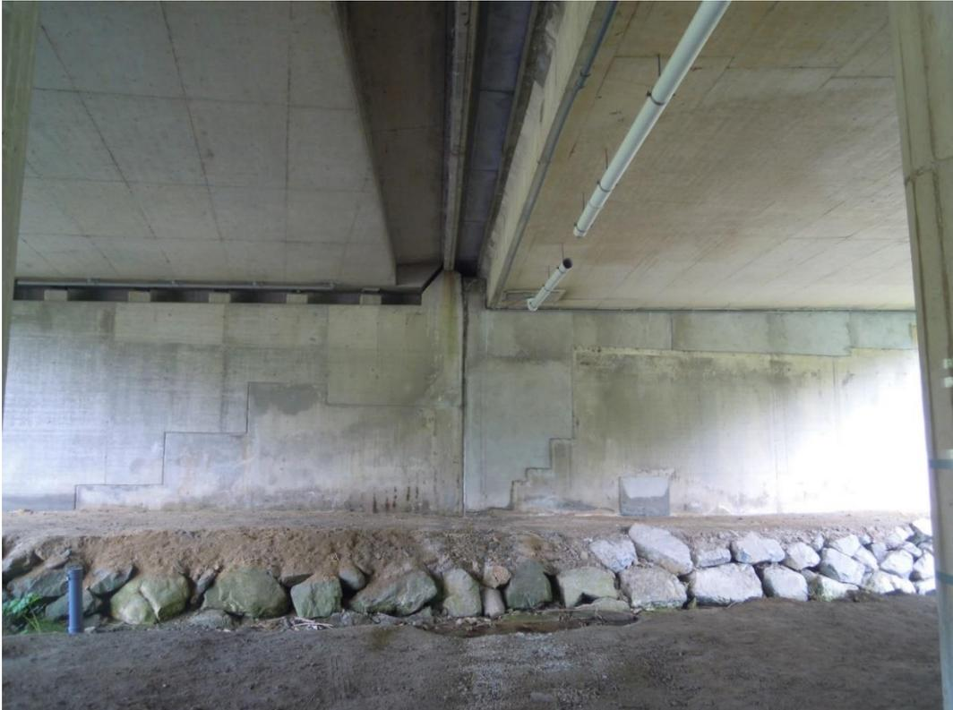
Abbildung 3: Steinbachbrücke; rechts integrale links konventionelle Ausführung
