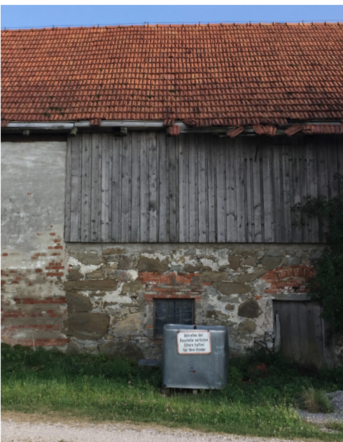
Rohes Feldsteinmauerwerk Salzmann, Aschach/Steier
