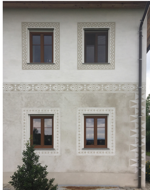
Sgraffitoputz beim Hinterzaunergut, Aschach/Steyr
