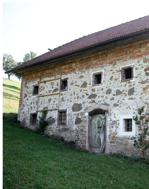
Rohes Feldsteinmauerwerk Bachmayrgütl, Aschach/Steier
