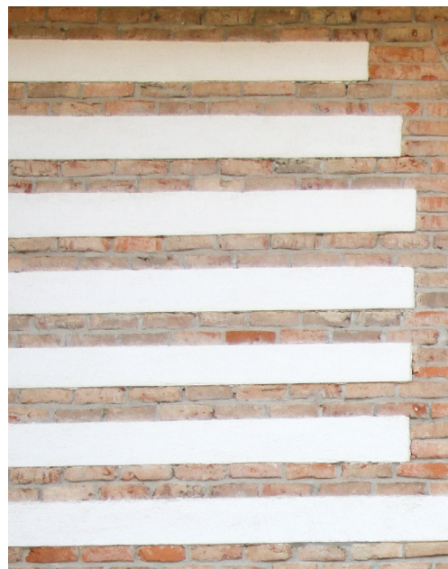
Schichtenmauerwerk mit verputztem Füllmaterial - opus romanum Roller, Aschach/St.
