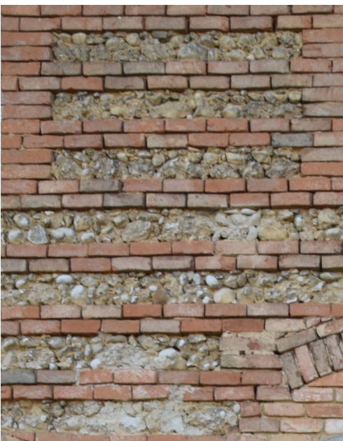
Schichtenmauerwerk mit unverputztem Füllmaterial
