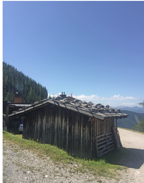
Hütte mit Legschindeldach
