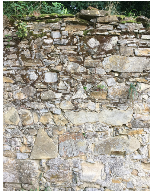
Rohes Feldsteinmauerwerk Hochzauner, Aschach/Steier
