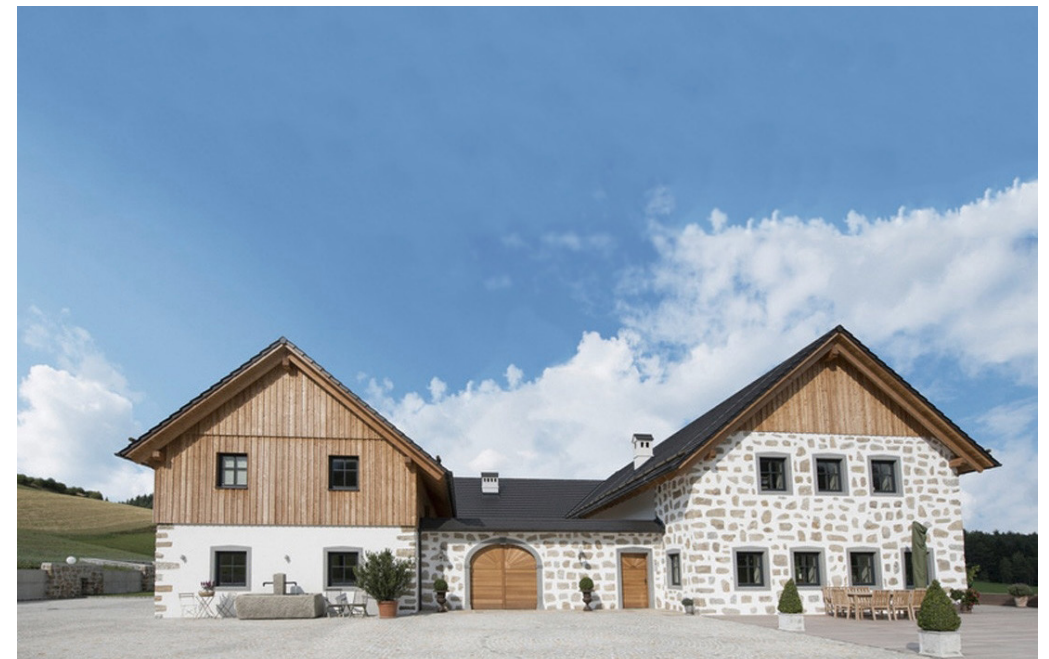
Abb.23: Dreikanthof im Mühlviertel mit Blaßsteinmauerwerk
