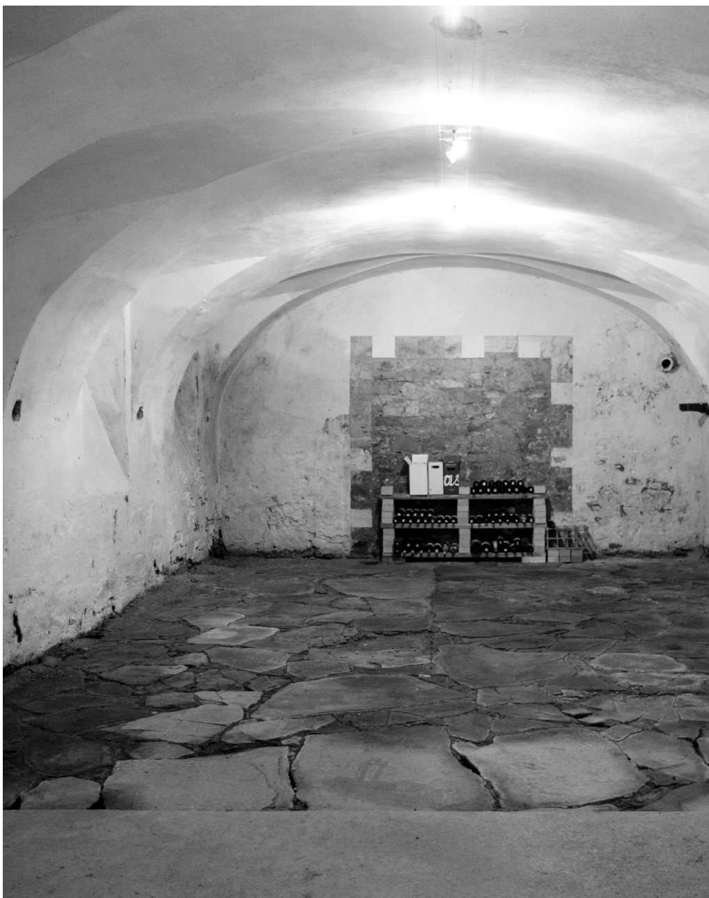
Der Gewölbekeller mit Granitboden
