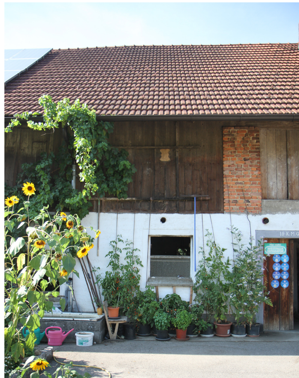
Loarwände im Obergeschoß Bachner in Aschach an der Steyr
