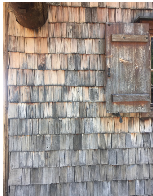
Schindelfassade auf einer Hütte
