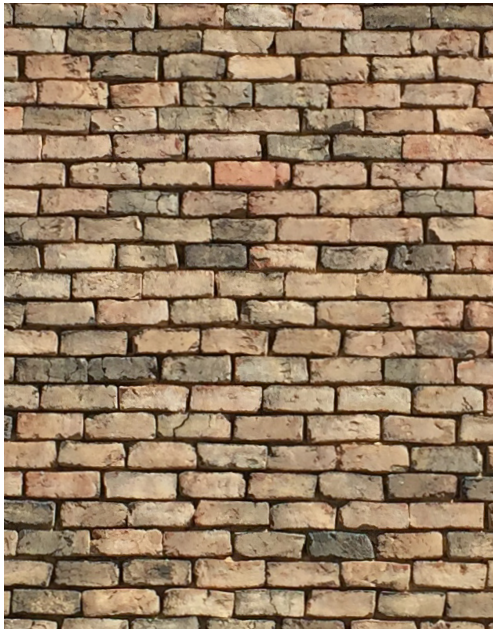
Mauerwerk mit Sichtziegeln getrocknet
