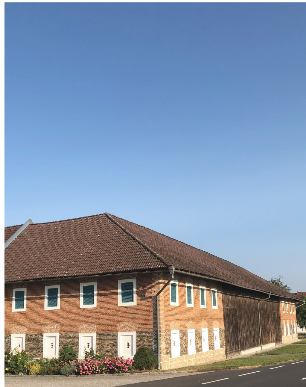
Vollziegelbau mit Eisenziegeln im Sockelbereich Kroismayr in Kronstorf
