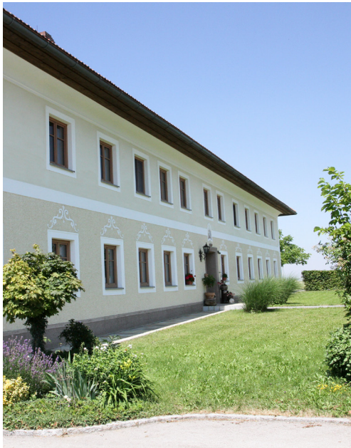
Putzfassade beim Hochhubergut, Aschach/Steyr
