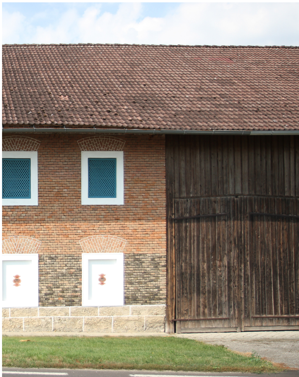
Loarwände im Kontrast zum Ziegelbau Kroismayr in Kronstorf
