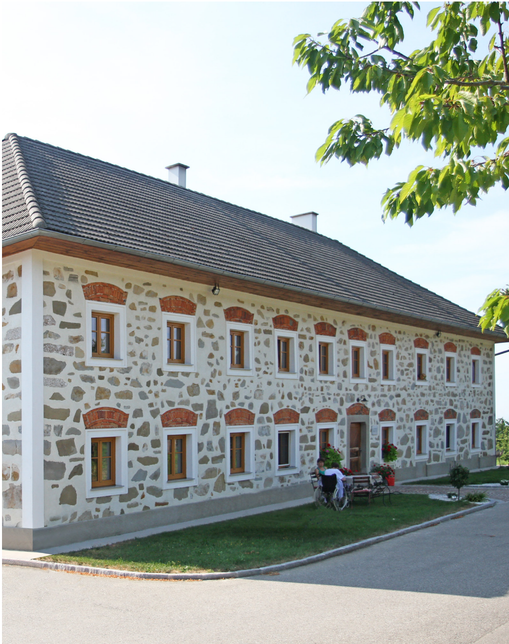
Blaßsteinmauerwerk Aichner, Aschach/Steyr
