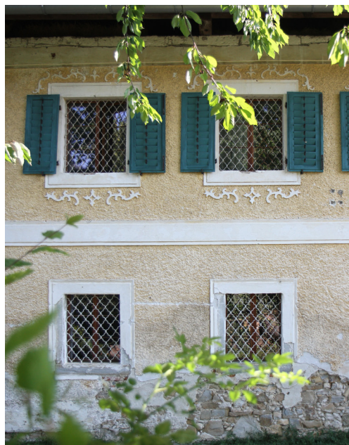
Rieselputzfassade mit Stuckzierrate aus 1836, beim Gsöllhof in Steinbach/St.
