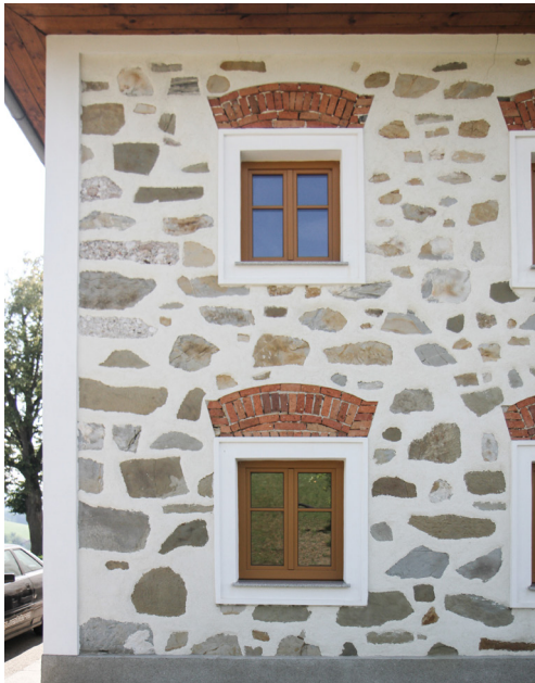
Bloßsteinmauerwerk Aichner, Aschach/Steier
