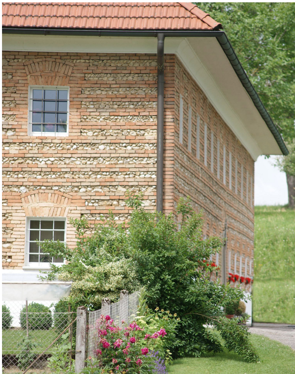
Abb.24: Schichtmauerwerk mit Flusststeinen - opus spicatum Hainbuchnergut, Matzelsdorf
