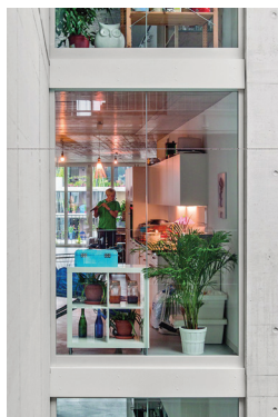
Abb 03 Verglasung zu Stiegenhaus
