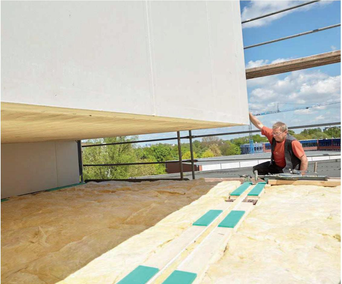
Abb. 12: Versetzen der Raummodule
