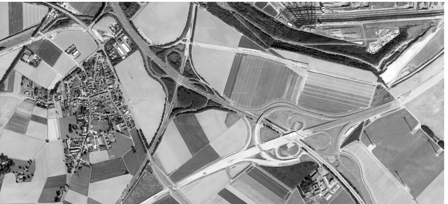
Bau der Auffahrt auf die A44n (oben) und das Autobahnkreuz Jackerath, um einen Kilometer nach Osten versetzt (unten)
