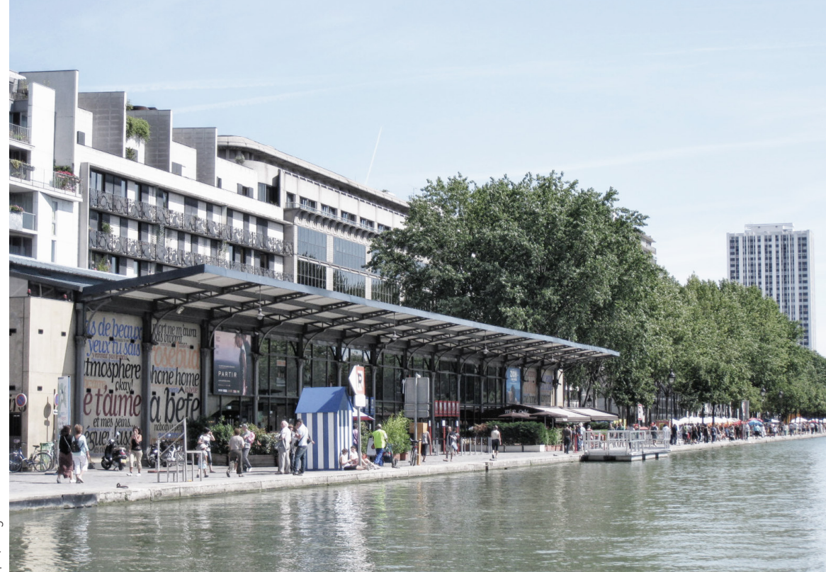
40 | Angrenzende Uferzone mit Cafes
