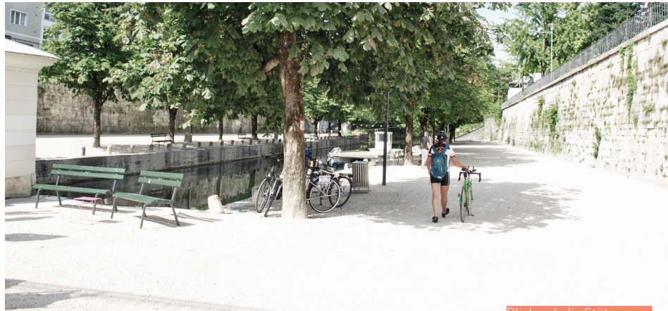
Blick auf die Stützmauer
