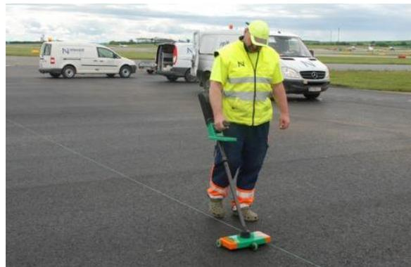
Abbildung 25: Zustandserhebung mittels Planograph (47069566-Bauliche-ausgabe-di-r-veit-egeberer-di-dr-m-buchta-di-p-furtner-eine-grundlage-fuer-das-erhaltungs-management-der.html, letzter Zugriff: 07.08.2018)
