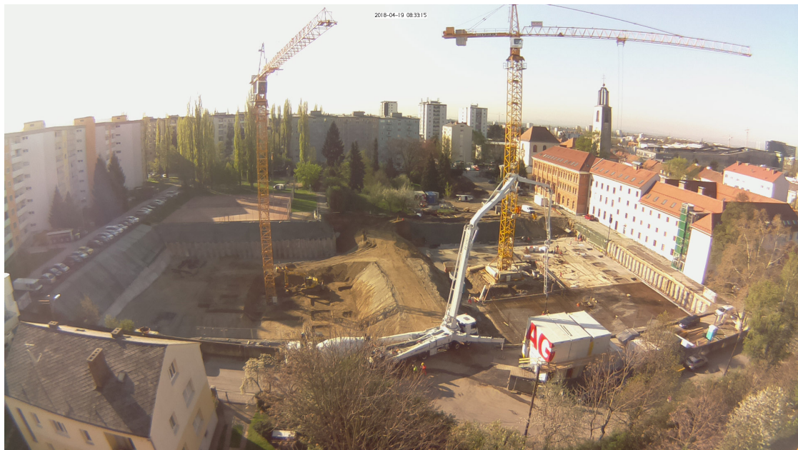
Abbildung 8.3.: Aufnahme vom 18-04-19, 8:33:15, Betonpumpe im Einsatz
