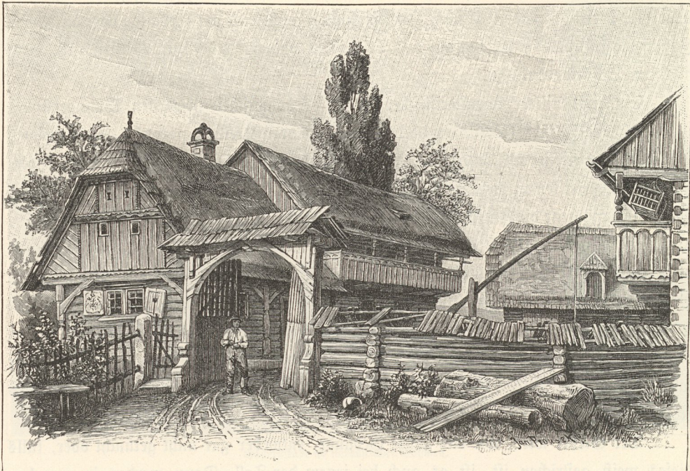
Holzgebäude bei Turnau.
