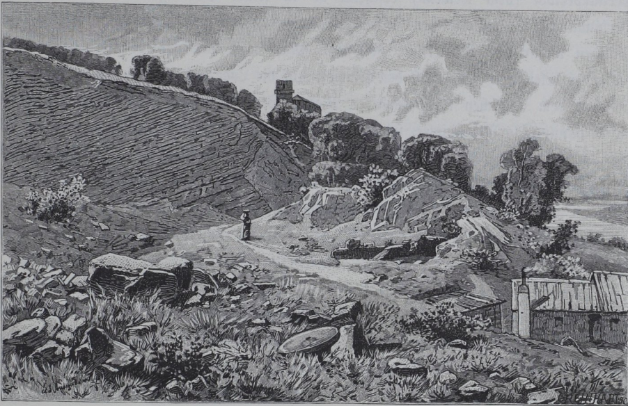
Der Steinbruch bei Greifenstein im Wiener Sandstein.
