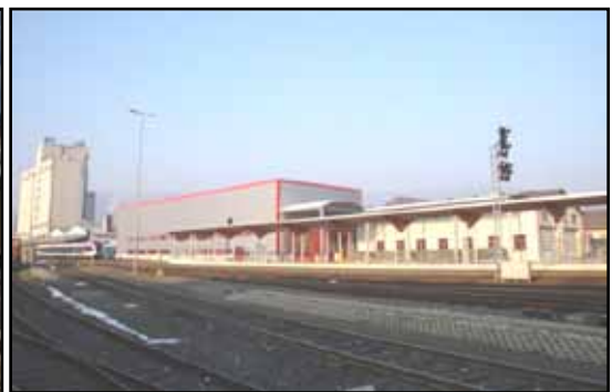
Abb. 1.4: Ansicht der neuen Servicehalle im Jänner 2011
