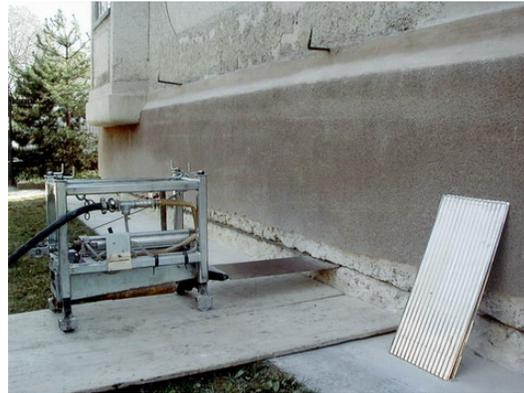
Abb. 5. 7: Einbau mittels Presslufthammer [33]
